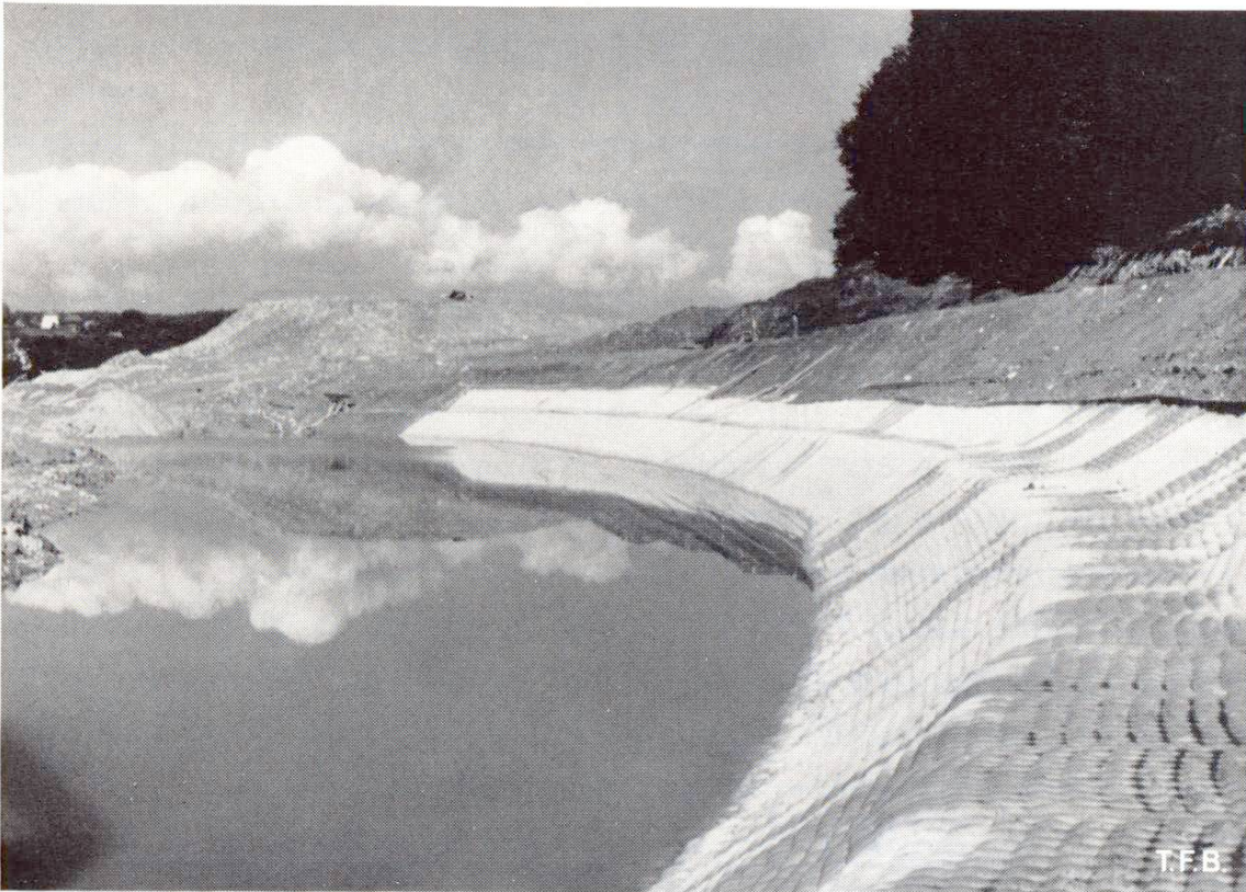
Fig. 10 Vue générale du chantier.
