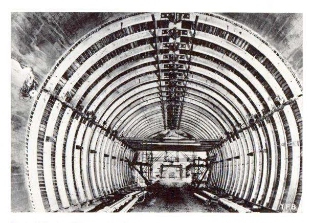
Fig. 5 Utilisation d'éléments de coffrage en aluminium.
