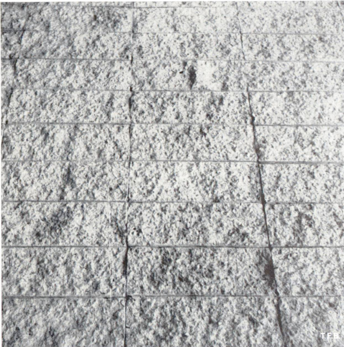
Fig. 4 Maçonnerie à joints très minces,
