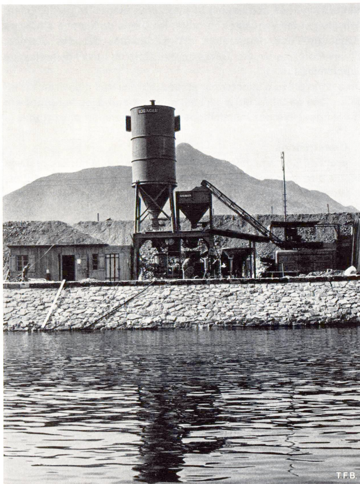
Fig. 2 Installation pour la préparation du mortier Colcrete avec malaxeur spécial de 350 l.
