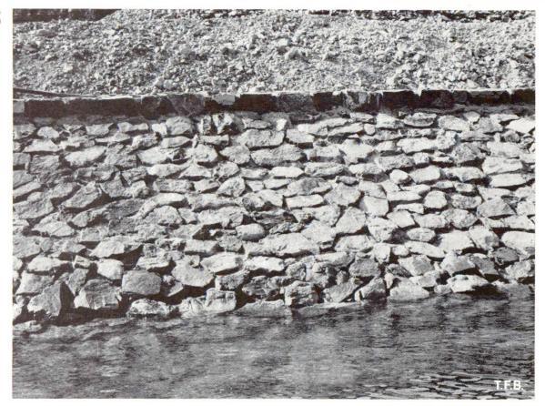
Fig. 5 Vue du talus revêtu en béton Colcrete.
