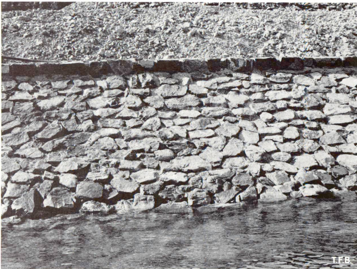
Fig. 5 Vue du talus revêtu en béton Colcrete.
