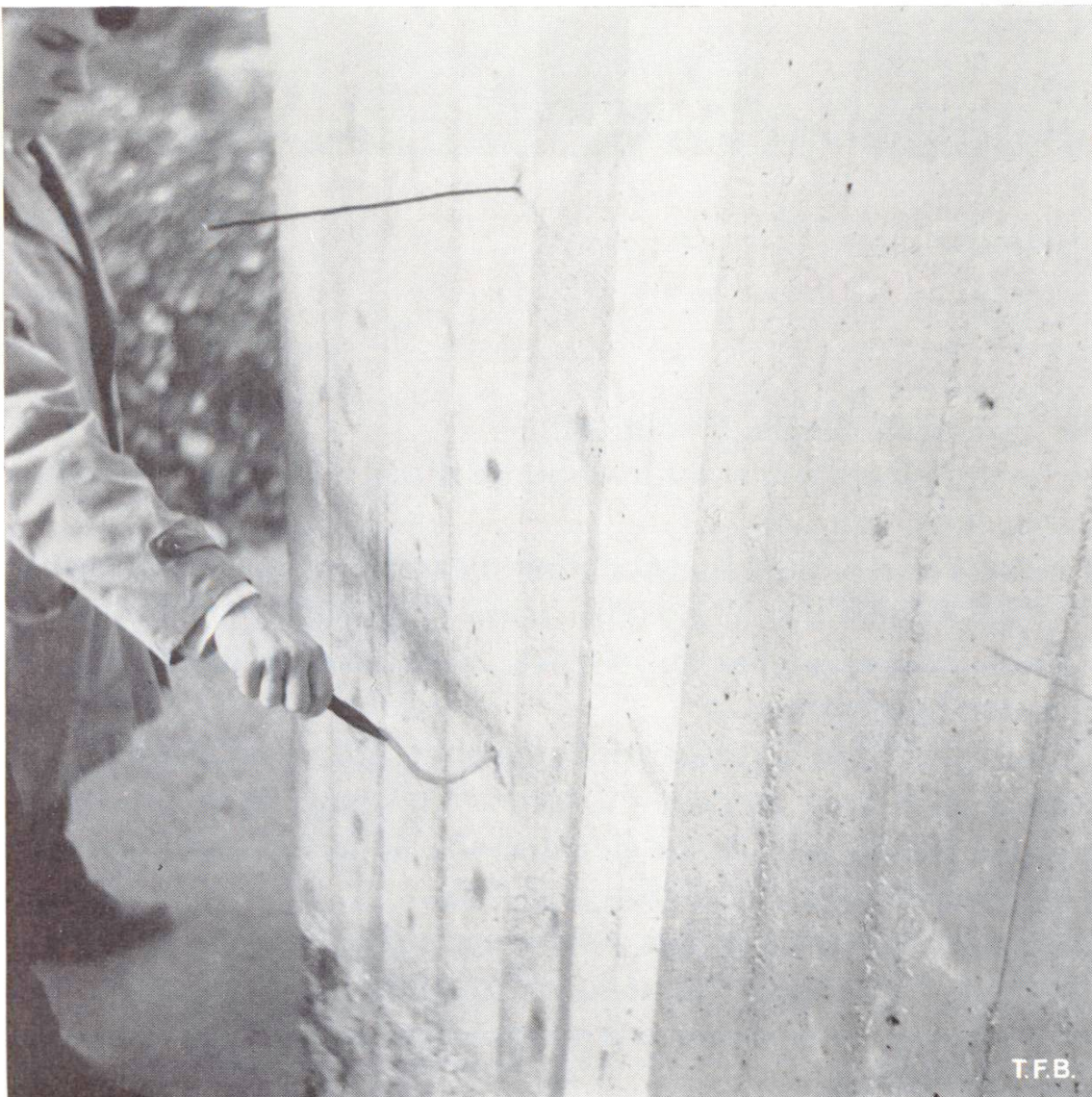
Fig. 7 Fils de liaison et tuyaux en plastique sont faciles à retirer.
