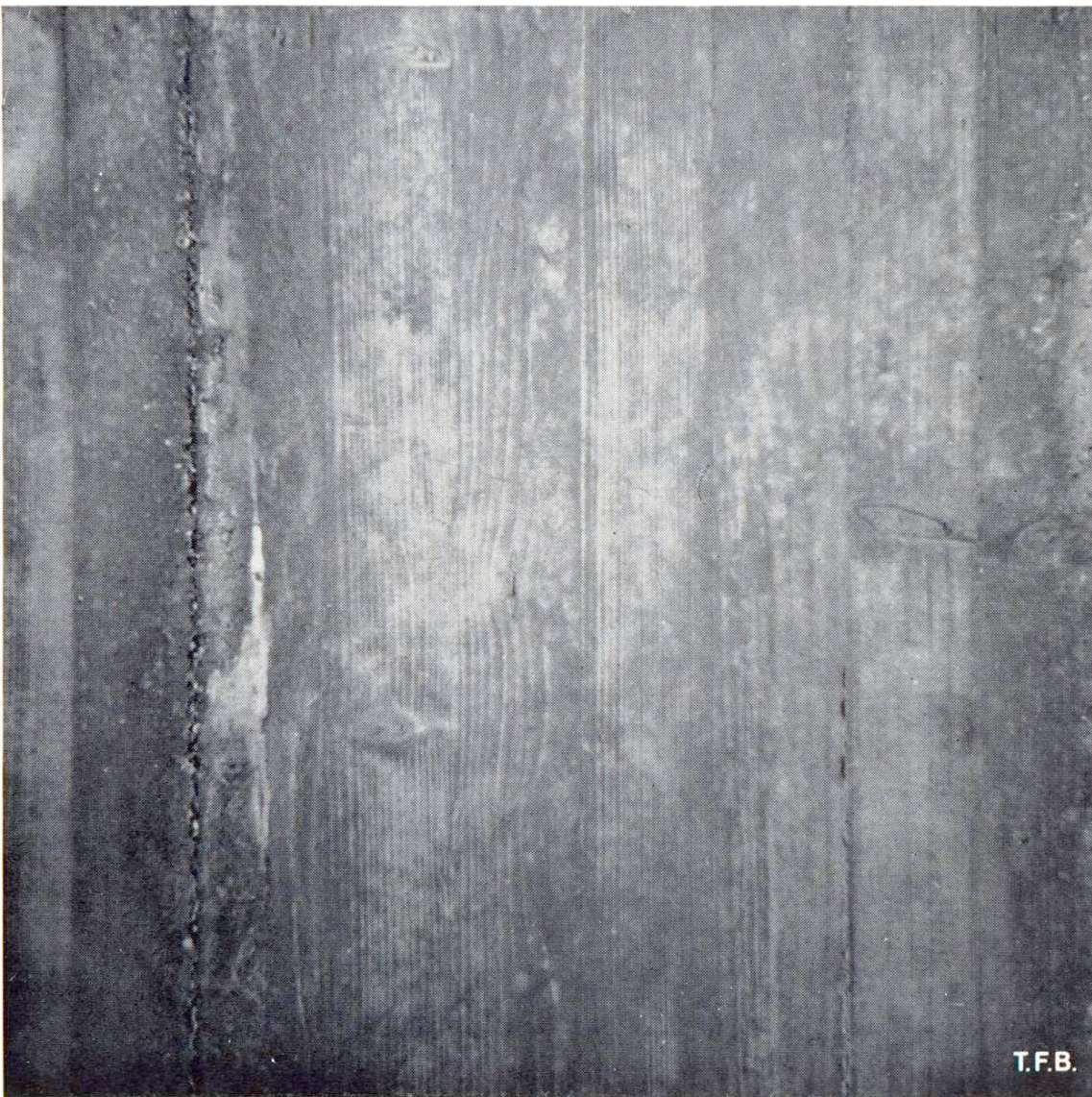
Fig. 5 Béton apparent à coffrage en panneaux préfabriqués.
