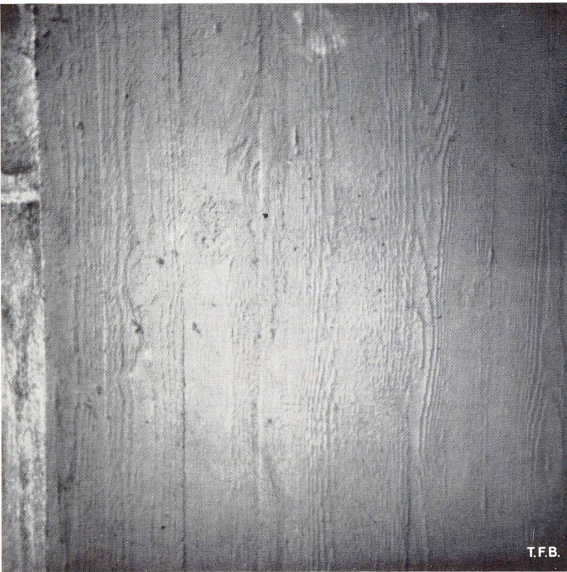
Fig. 4 Béton apparent à coffrage en planches brutes.
