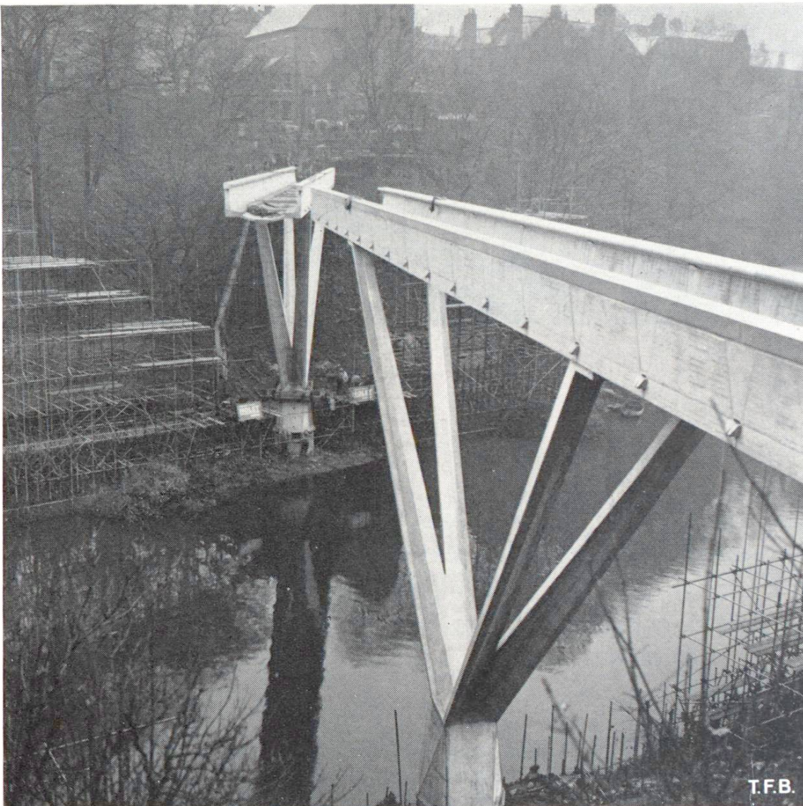
Fig. 3 Vue prise pendant la manœuvre de pivotement.
