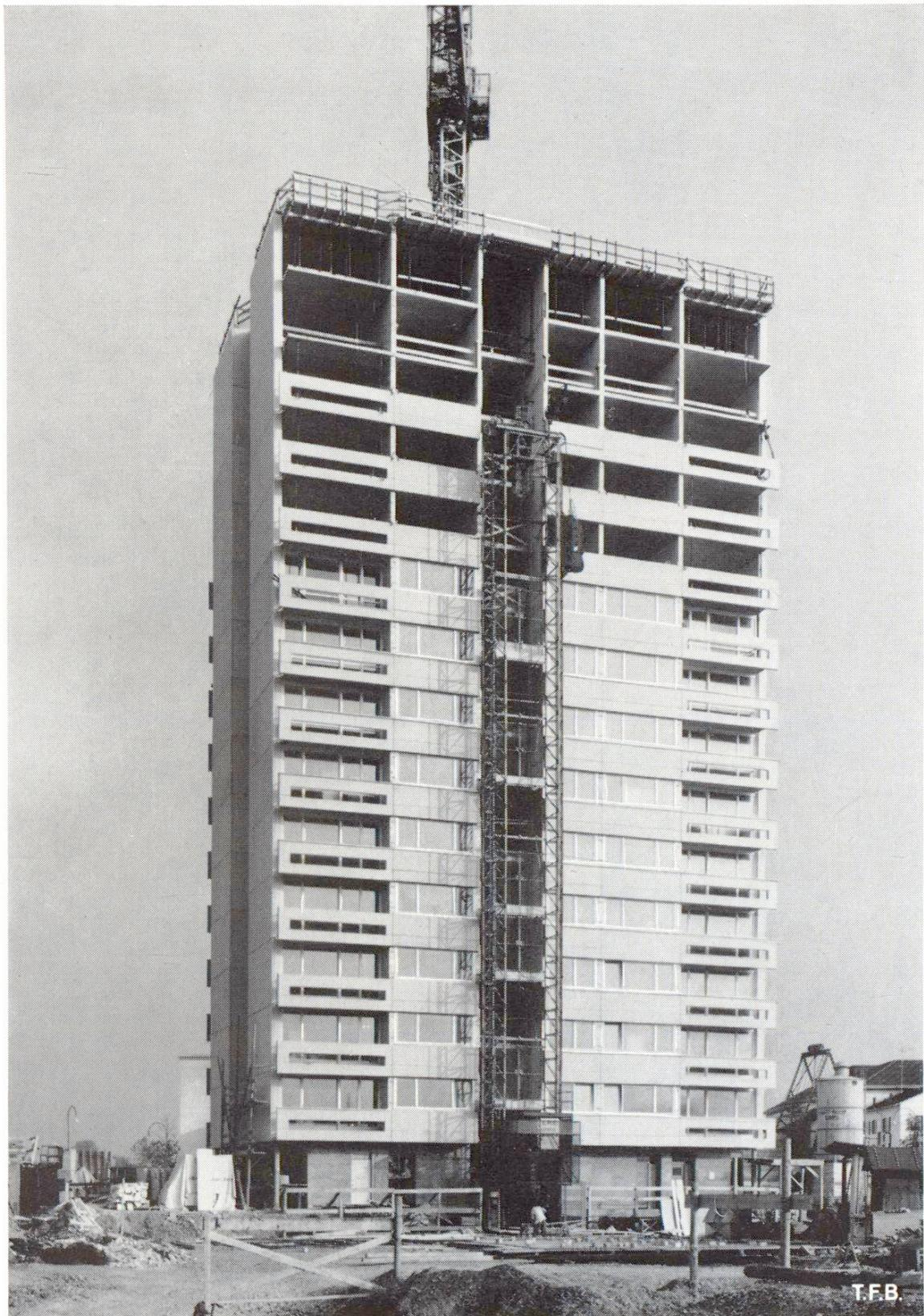
Fig. 3 Immeuble-tour construit à Zurich en 1963 par l'entreprise H. Hatt-Haller selon la technique «toutbéton». Les éléments de façade ainsi que les parapets des balcons sont en béton préfabriqué.
