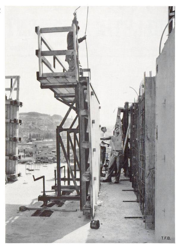
Fig. 1 Elément de coffrage de paroi comportant une passerelle de travail. On distingue la charpente métallique ainsi que les vérins à vis permettant un réglagé précis et rapide. L'élément vient d'être déposé par la grue. A gauche, on voit l'extrémité d'un autre élément, avec le dispositif de fixation par corchets métalliques et coins.
