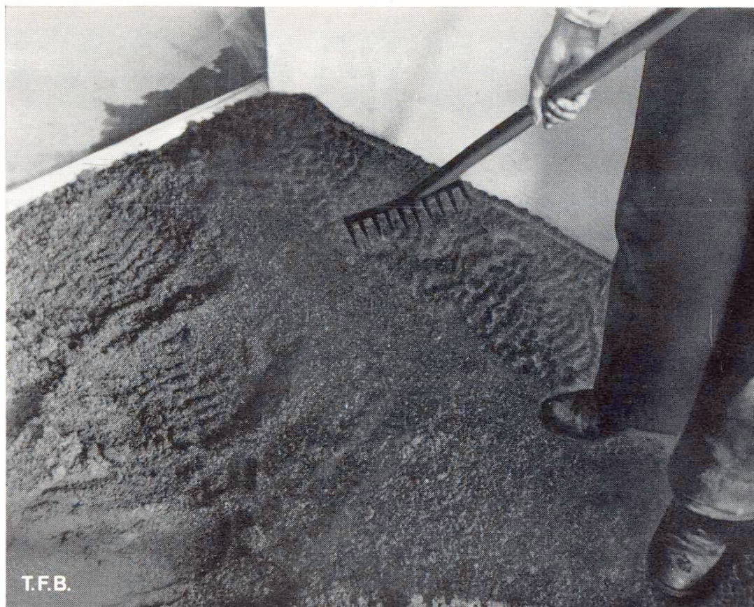
Fig. 1 Le mortier est égalisé sommairement au râteau
