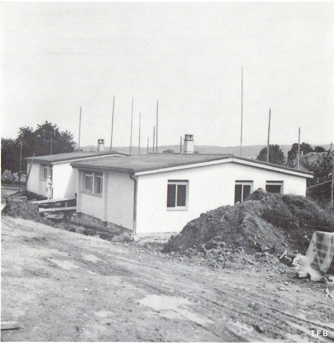
Fig. 11 Maison préfabriquée pour le logement du personnel. Jolie maisonnette spacieuse et ensoleillée pour une famille. Là aussi, on a pensé au pratique: tout est sur un étage afin de faciliter le travail de la ménagère.
