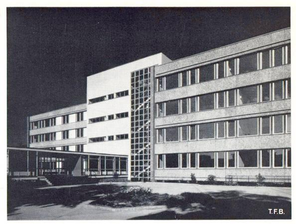
Fig. 7 Bâtiment scolaire en Allemagne avec façade en éléments préfabriqués de béton lavé. L'exécution de béton lavé étant délicate, il est souvent avantageux de la combiner avec la préfabrication sur le chantier ou en atelier.
