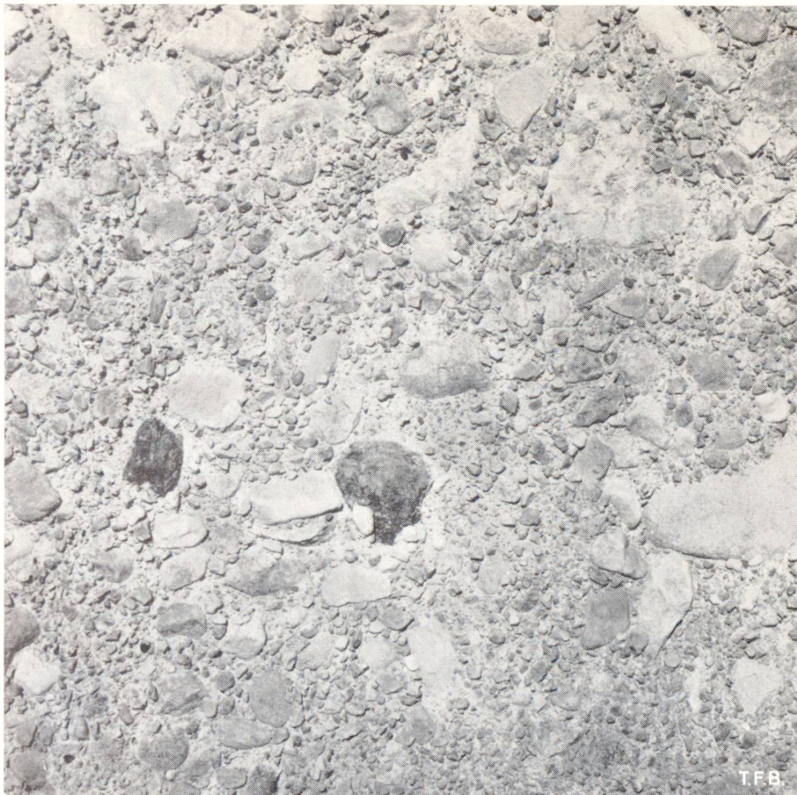
Fig. 1 Béton lavé. Granulats morainiques de grain maximum 100 mm.
