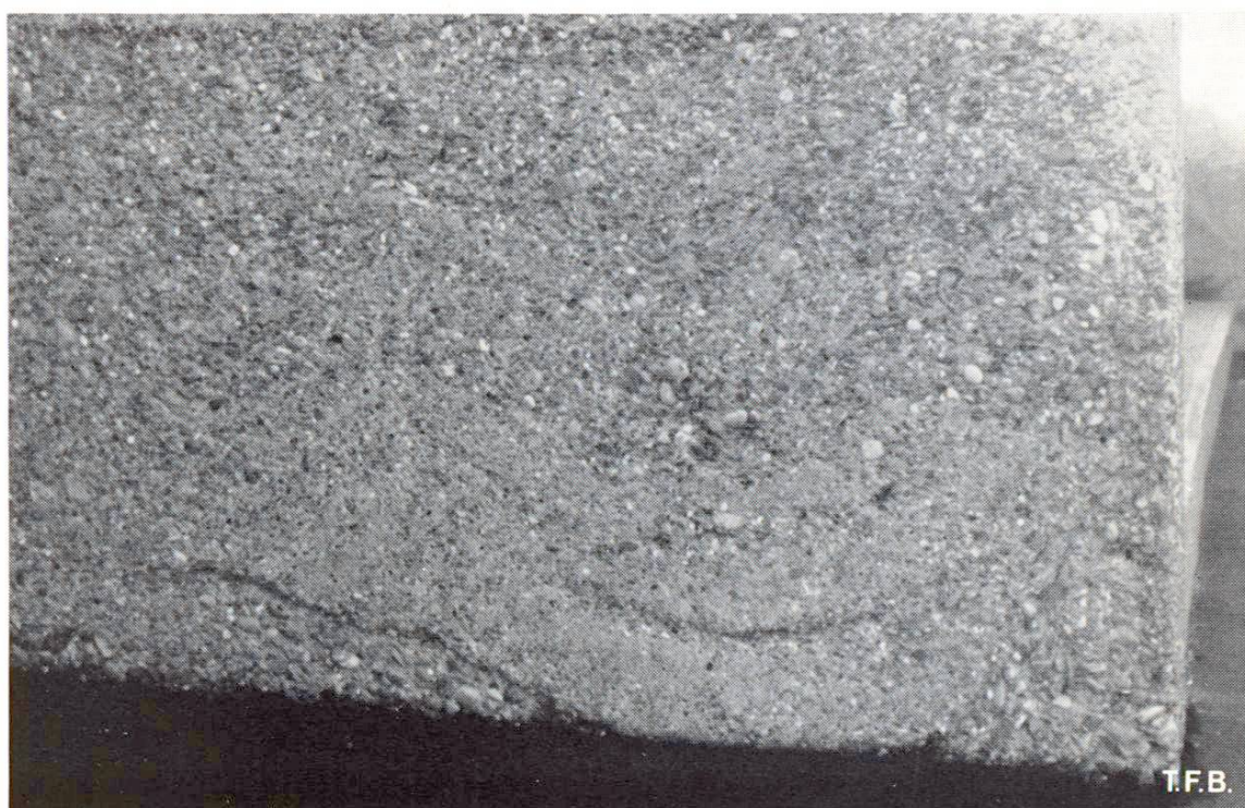
Fig. 6 Au bas de ce mur, ségrégation typique due à une mauvaise mise en place du béton. Dans le béton lavé, de tels défauts ne peuvent plus être corrigés.
