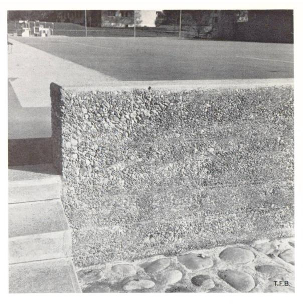
Fig. 5 Béton lavé montrant une légère ségrégation et l'image des joints des planches de coffrage. Cette photo offre un exemple intéressant d'applications variées du béton dans un aménagement de jardin.
