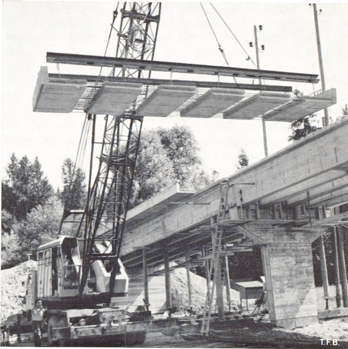
Fig. 6 Montage du tablier.
