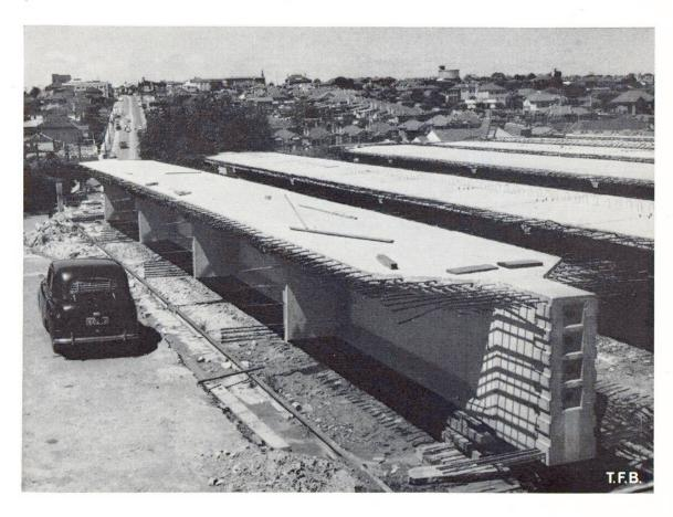
Le montage se fait sur un cintre métallique de la largeur d'un arc qui sera réutilisé quatre fois. Les éléments d'arc sont amenés par chalands, hissés au sommet de la voûte par un élévateur, puis déplacés de chaque côté le long du cintre jusqu'à leur position définitive. Après la pose de tous les éléments d'un arc, celui-ci est mis en compression par des vérins hydrauliques et légèrement soulevé. Le cintre peut alors être ripé à l'emplacement de l'arc suivant.
