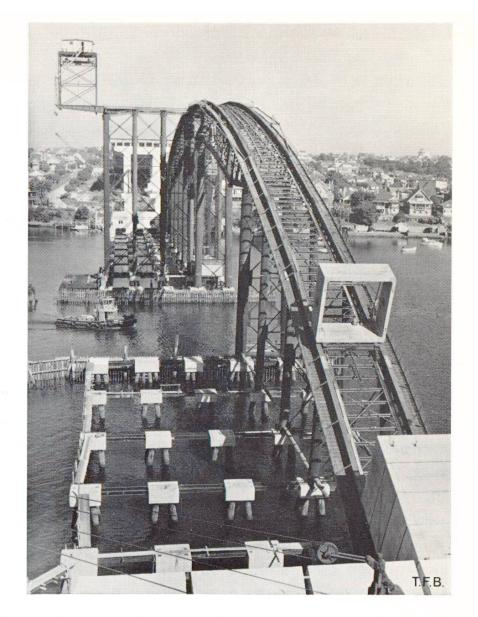
Fig. 3 Le cintre, avec la passe de navigation. Un des éléments d'un arc est en déplacement vers sa position définitive.
