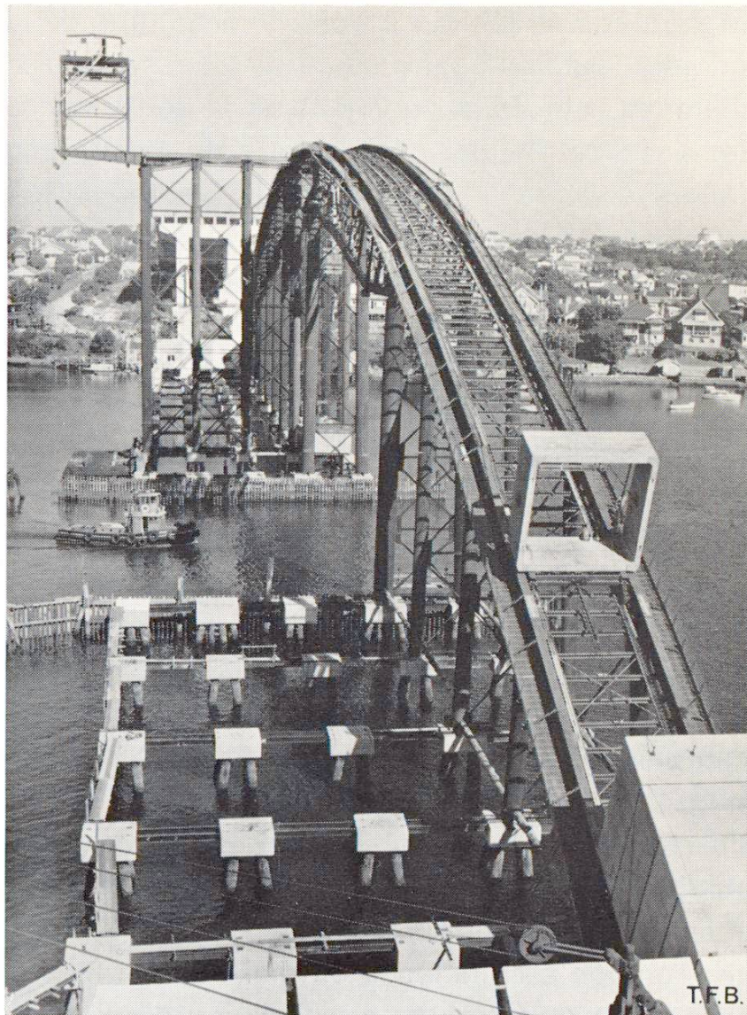
Fig. 3 Le cintre, avec la passe de navigation. Un des éléments d'un arc est en déplacement vers sa position définitive.
