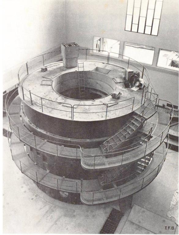
Fig. 1 La grande œuvre d'un réacteur. La photo montre bien l'épaisseur de la paroi protectrice en béton lourd.
