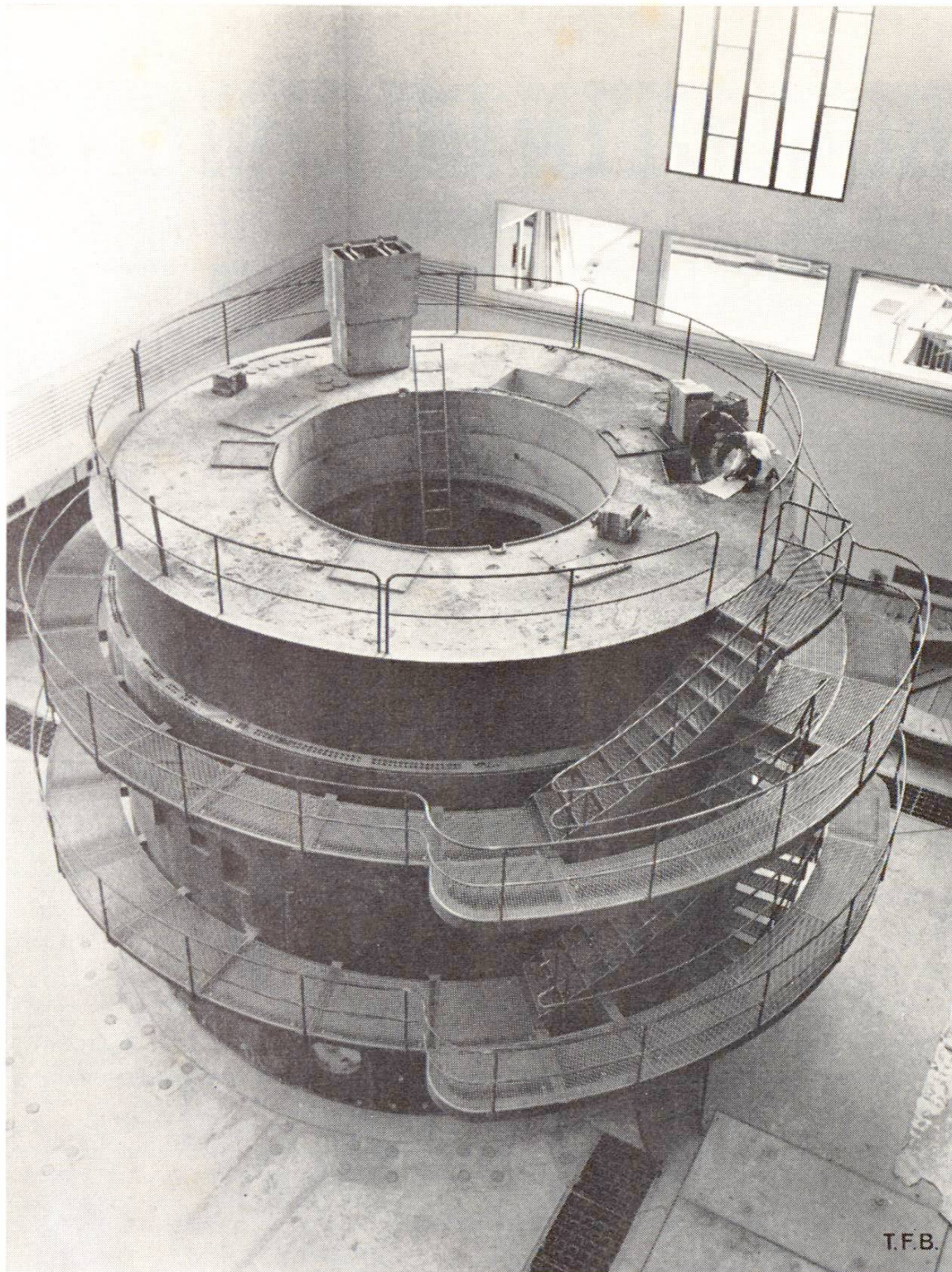
Fig. 1 La grande œuvre d'un réacteur. La photo montre bien l'épaisseur de la paroi protectrice en béton lourd.
