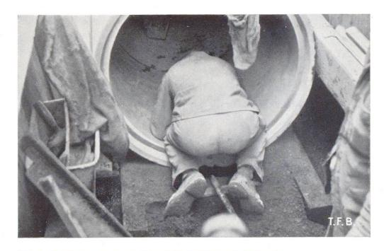
Fig. 7 Pose des tuyaux sur la semelle fraîchement bétonnée
