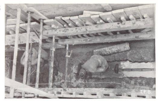
Fig. 6 Drainage de la semelle en béton
