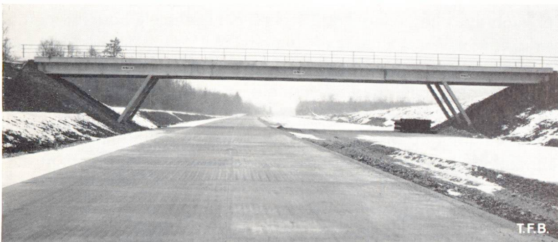
Fig. 4 Un pas en avant: Les ponts préfabriqués en série et montés pour les passages supérieurs de routes d'améliorations foncières sur l'autoroute Genève-Lausanne. Projet: Soutter & Schalcher, ing. dipl., Zurich. Préfabrication: Igéco S.A., Etoy VD.
