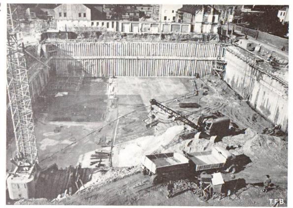
Fig. 1 Blindage des parois d'une fouille par le système BENOTO en piles sécantes type 880/750. Fondation du bâtiment de la Radiodiffusion bavaroise, Munich.
