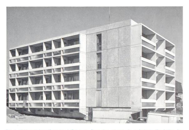
Fig. 4 Bâtiment locatif moyen à Fribourg. Pour des raisons de technique d'isolation, les balcons sont construits séparément du reste de l'édifice. Comme moyen d'expression architectonique, on a réalisé deux différentes structures de surface du béton (Architectes: A. Décoppet, L. Veuve et F. Aubry, Lausanne. Ingénieurs: Bureau d'études S. A. Conrad Zschokke, Genève et Bureau technique Igéco S.A., Etoy. Préfabrication: Igéco S.A. Etoy. Montage: Entreprise SATEG S.A., Fribourg.)
