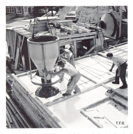
Fig. 2 Préfabrication de dalles avec isolation, sur le chantier même. La photo montre le bétonnage d'une dalle sur une pile dont elle est la 8° couche. L'épaisseur des dalles est normalisée, les coffrages des bords, très simples, sont posés les uns après les autres. L'armature a pour seul but d'éviter des ruptures lors des manutentions pour la mise en place ultérieure des éléments.
