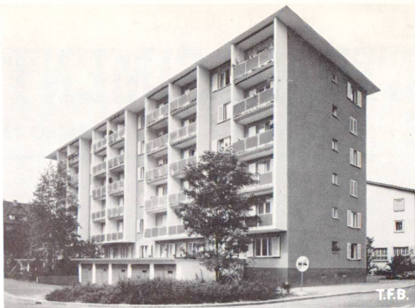
Fig. 1 Bâtiment locatif à Dietikon (ZH) construit entièrement en béton préfabriqué sur le chantier (Projet et exécution: D. Lanfranconi, Zurich).
