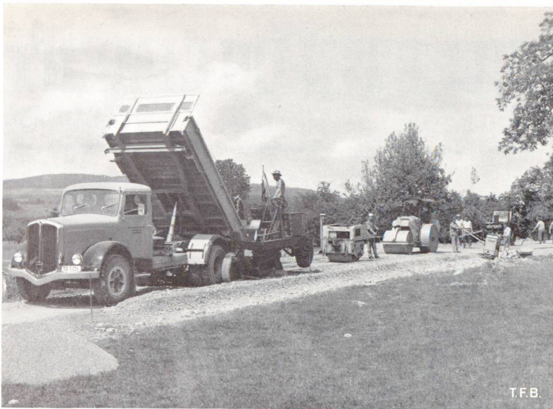
Fig. 1 Construction d'un chemin avec matériaux stabilisés selon le procédé mix in plant. On reconnaît au premier plan l'arrivée des matériaux préparés en centrale et le remplissage de l'engin répandeur. Derrière, les rouleaux, puis le giclage de la pellicule d'émulsion bitumineuse.
