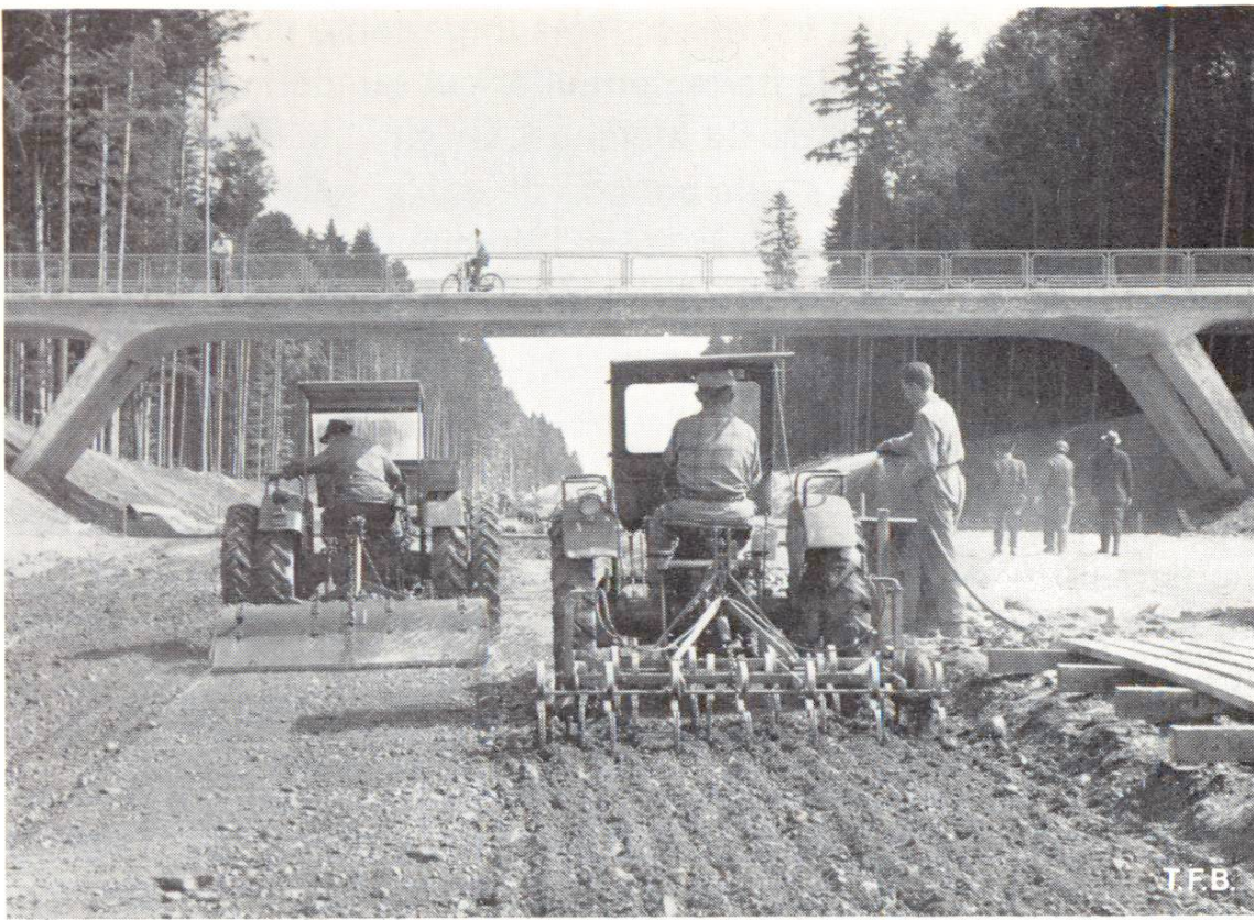
Fig. 5 Ameublissement, arrosage et malaxage de la couche à stabiliser
