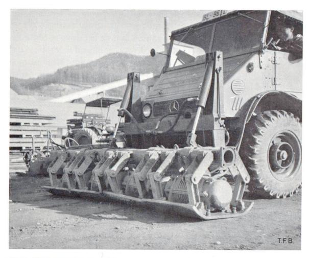
Fig. 4 Vibrateur à plaques multiples.
