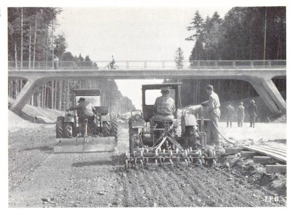
Fig. 5 Ameublissement, arrosage et malaxage de a couche à stabiliser
