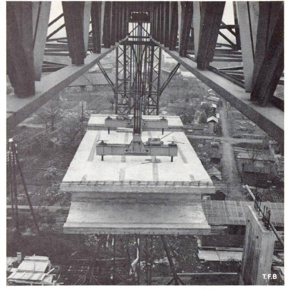
Fig. 5 Un élément de 50 t soulevé et mis en place par le portique.
