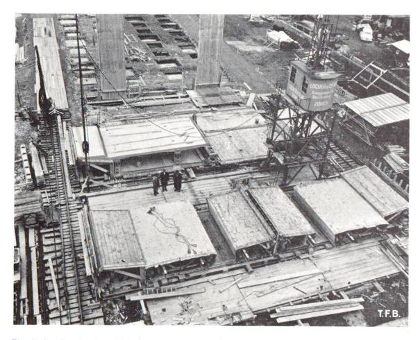
Fig. 4 Le chantier de préfabrication à Altstetten. A gauche et à droite, aux bords de la photo, les rails du portique de pose. A l'arrière-plan, les fondations du cintre.
