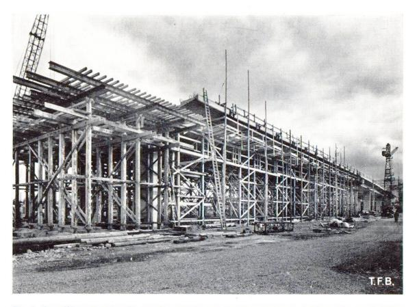
Fig. 7 Les éléments séparés par des joints bien visibles reposent sur le cintre avant d'être précontraints. A droite au fond, la première étape terminée.
