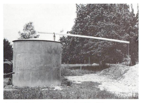
Fig. 6 Silo en élévation avec toiture munie d'un dispositif d'étanchéité Coût moyen, y compris fouille, évacuation des sucs avec puits de vidange, environ 55 francs par m³ de volume utile, sans dispositif étanche, environ 75 francs par m³ de volume utile, avec dispositif étanche
