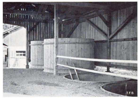
Fig. 5 Silos enterrés placés dans un hangar Coût moyen, y compris fouille, évacuation des sucs avec puits de contrôle et de vidange, mais sans couverture, environ 65 francs par m³ de volume utile
