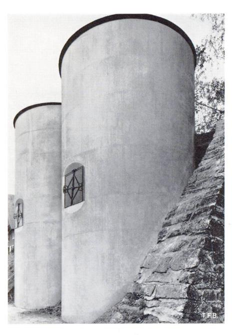
Fig. 8 Silos tours adossés à pont de grange Coût moyen du silo en béton de 3,00 à 3,50 m de diamètre et 6,00 à 10,00 m de haut, environ 45 francs par m<sup>3</sup> de volume utile
