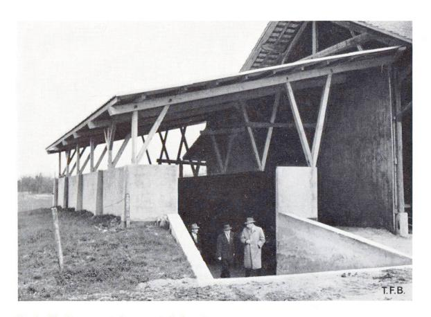
Fig. 4 Silo fosse avec toiture construit devant une grange Coût moyen, y compris fouille et évacuation des sucs, mais sans toiture, environ 40 francs par m³ de volume utile
