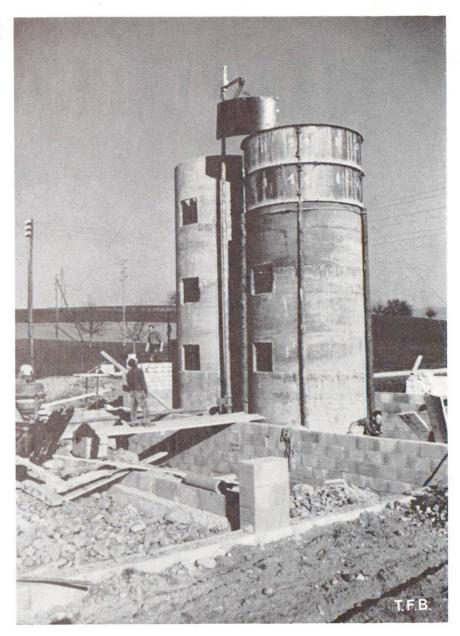
Fig. 2 Bétonnage de silos tours au moyen de coffrages glissants
