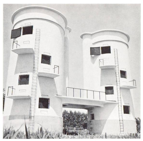
Fig. 9 Groupe de silos tour avec dévaloir à fourrage Coût, y compris presse mécanique, dévaloir à fourrage et passarelle, environ 105 francs par m<sup>3</sup> de volume utile
