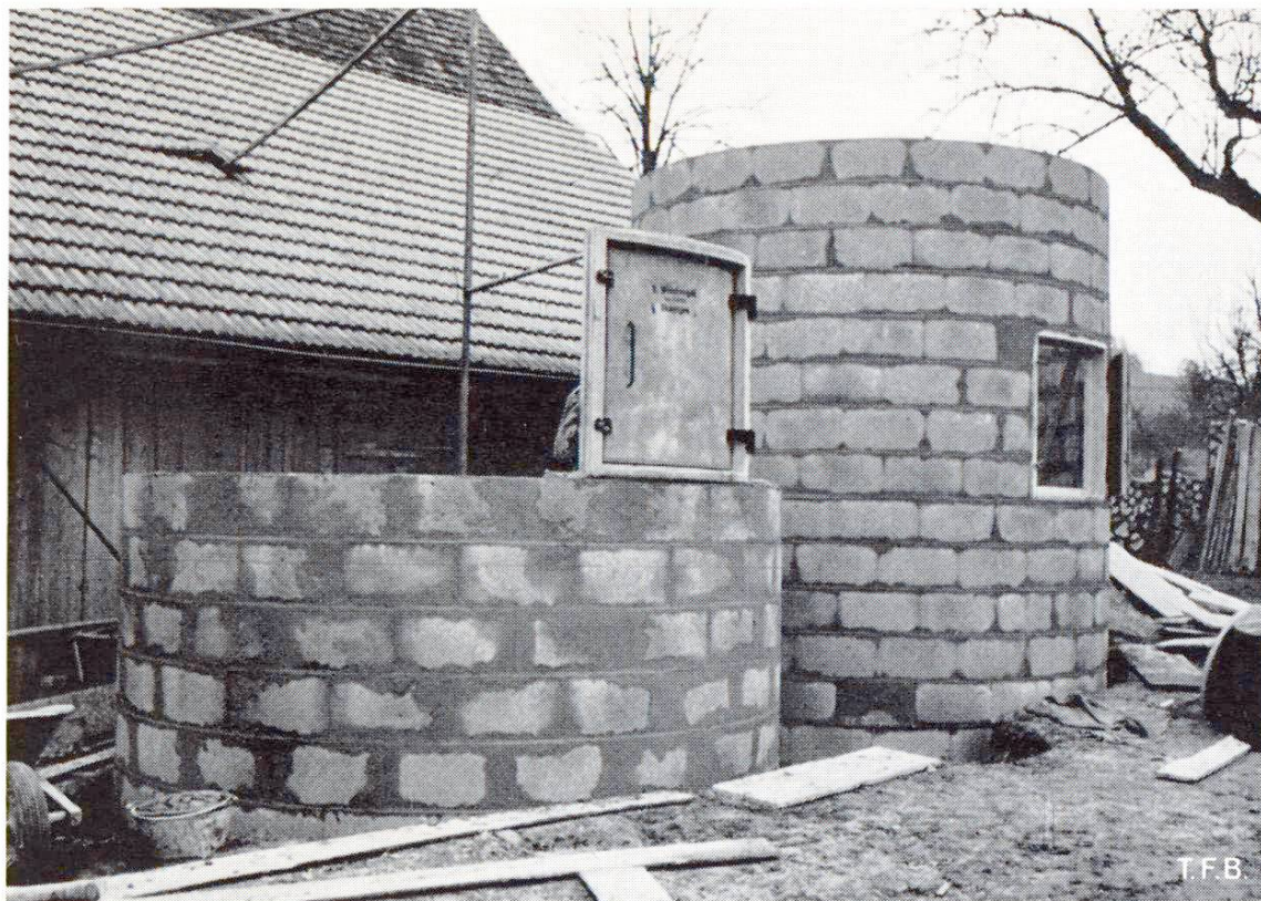
Fig. 3 Construction de silos en éléments préfabriqués
