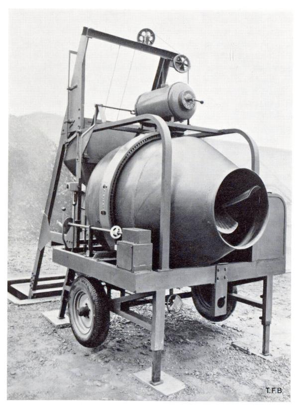
Fig. 3 Bétonnière à chûte libre pour un petit chantier. Vidange par inversion du mouvement de rotation du tambour
