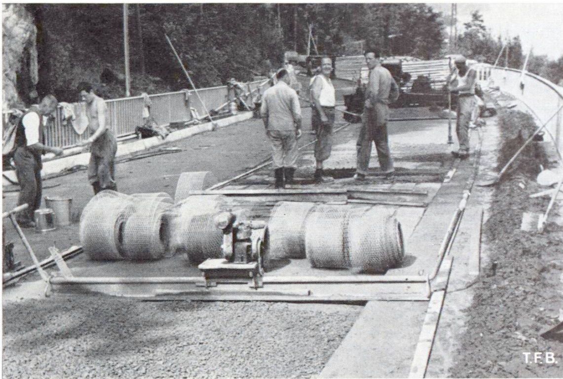
Fig. 3 Treillis chauffant, avant le bétonnage du revêtement du pont
