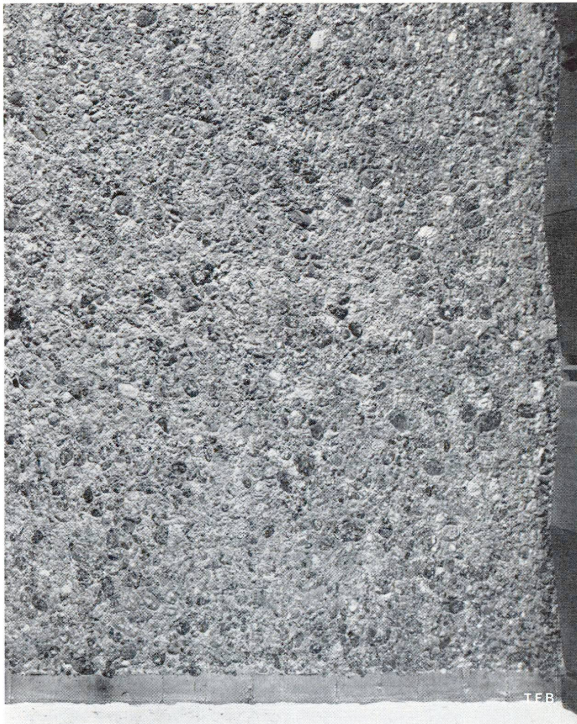
Fig. 5 Un béton composé d'agrégats à grains relativement gros, telle qu'apparaît sa surface après traitement à la boucharde. La partie inférieure non traitée forme socle
