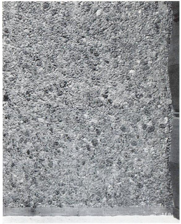
Fig. 5 Un béton composé d'agrégats à grains relativement gros, telle qu'apparaît sa surface après traitement à la boucharde. La partie inférieure non traitée forme socle
