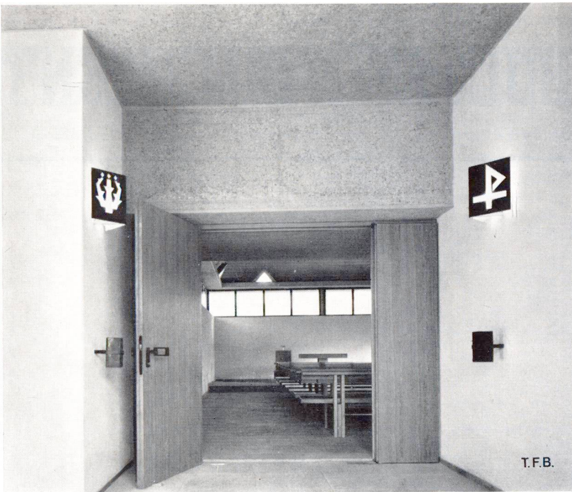
Fig. 1 Entrée avec plafond et linteau en béton bouchardé
