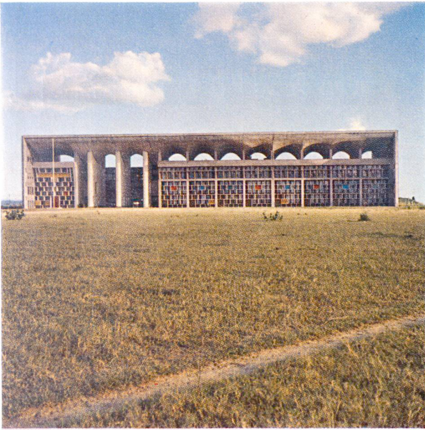
Fig. 1 Le Palais de Justice. Le toit aéré ne joue le rôle que de parasol et de parapluie
