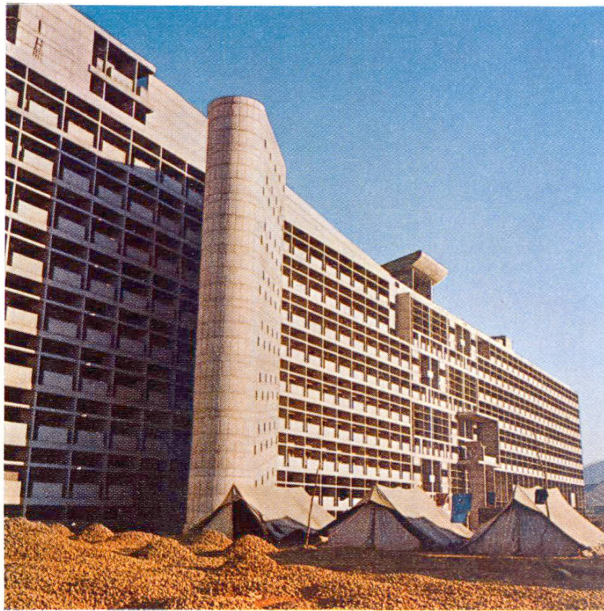
Fig 4 Le Secrétariat. Dans la tour placée devant la façade se trouve une rampe reliant les étages entre eux
