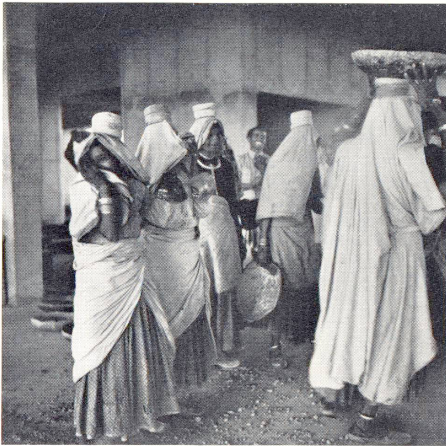
Fig. 3 Femmes transportant le béton à pied d'œuvre dans des cuvettes plates qu'elles placent sur leur tête
