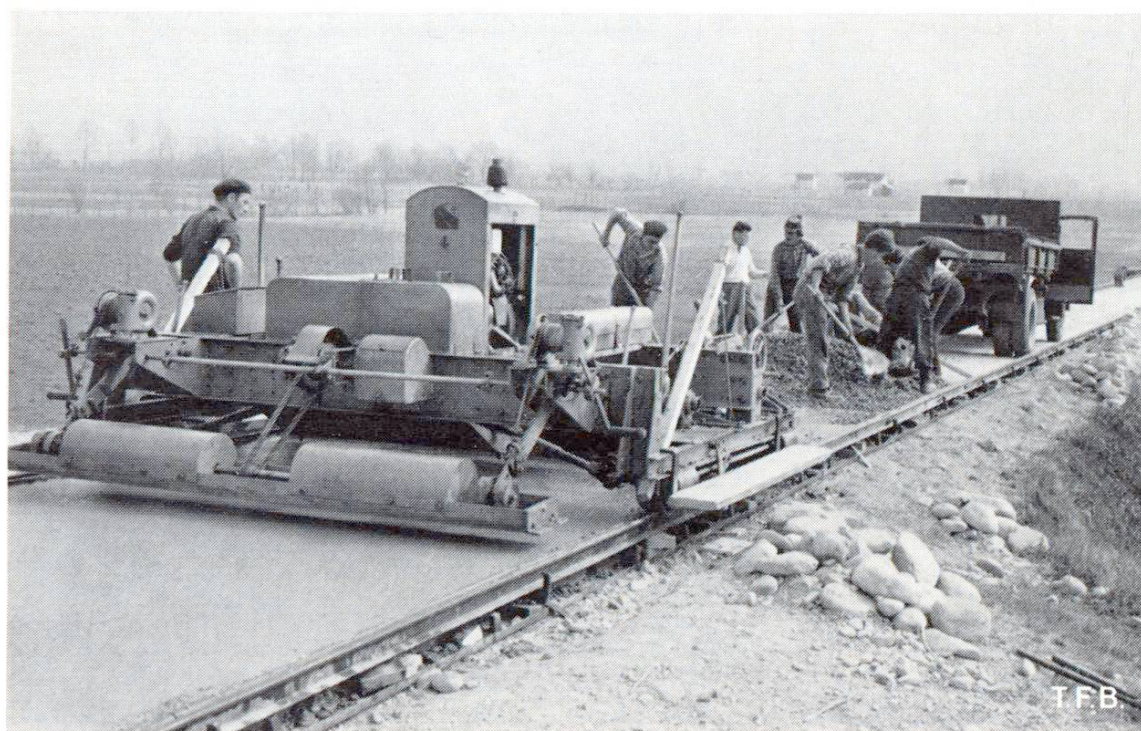
Fig. 4 Machine pour la construction d'un chemin en béton. La dalle a normalement 14 cm d'épaisseur, elle est légèrement armée. L'avancement journalier du bétonnage est de 150 à 250 m de chemin
