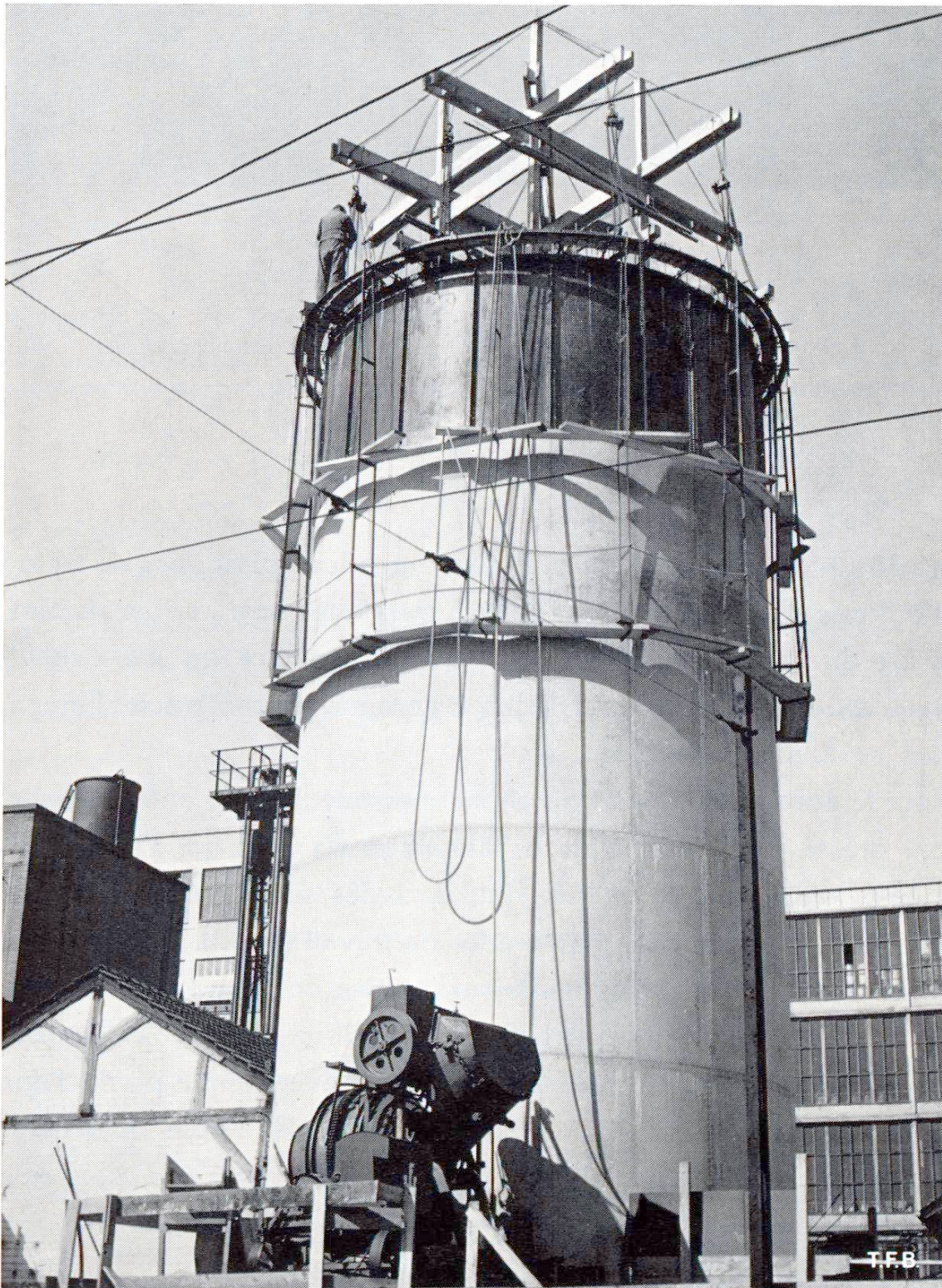
Fig. 3 Cheminée de la CIBA en construction
