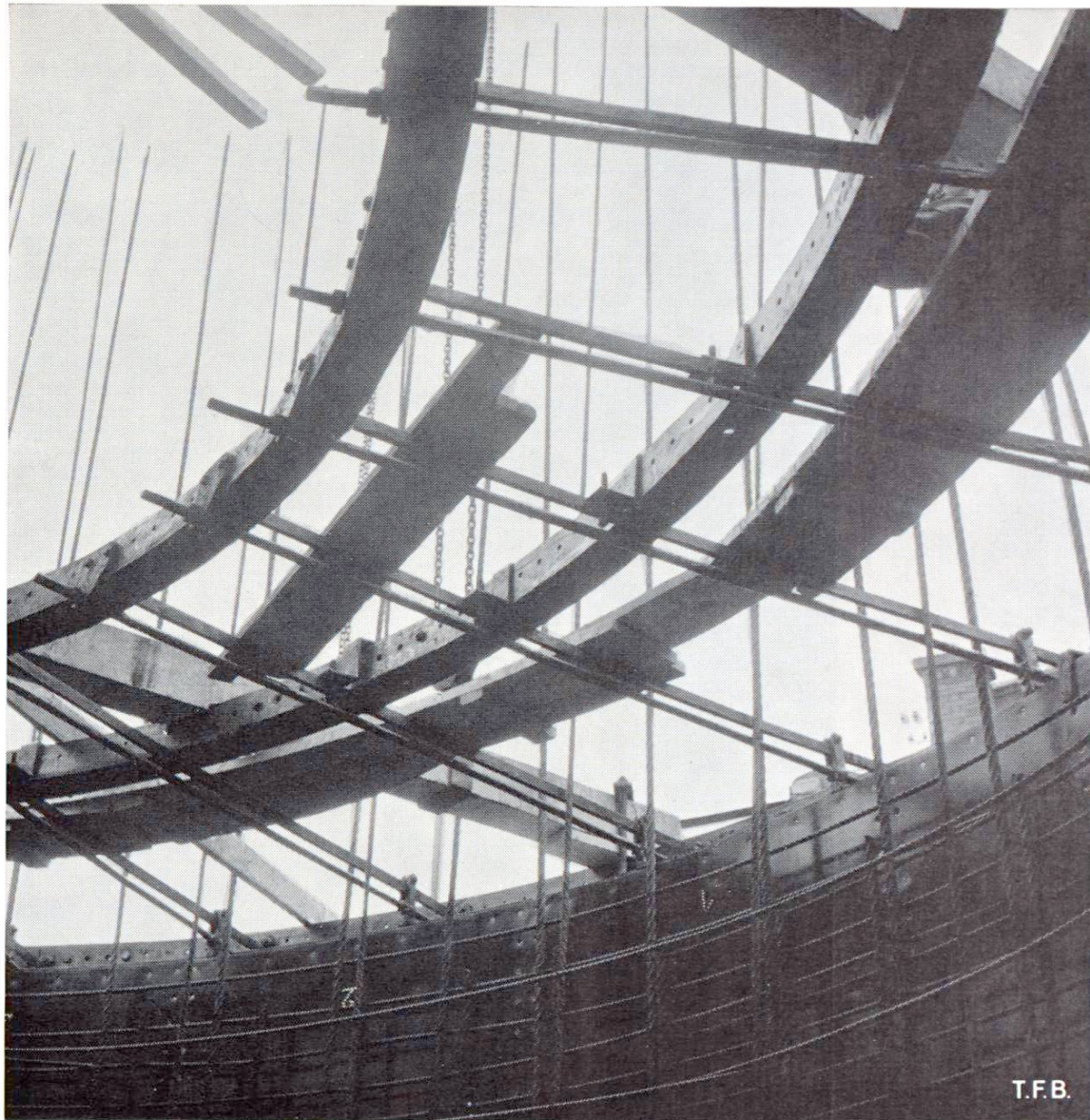
Fig. 4 Dispositif de réglage de la position des coffrages métalliques permettant de diminuer régulièrement le diamètre de la cheminée et l'épaisseur de ses parois à mesure qu'elle s'élève. (Cheminée CIBA)
