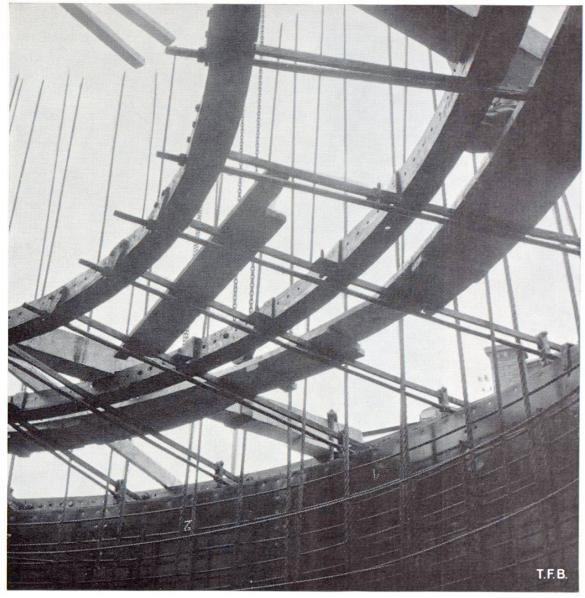
Fig. 4 Dispositif de réglage de la position des coffrages métalliques permettant de diminuer régulièrement le diamètre de la cheminée et l'épaisseur de ses parois à mesure qu'elle s'élève. (Cheminée CIBA)
