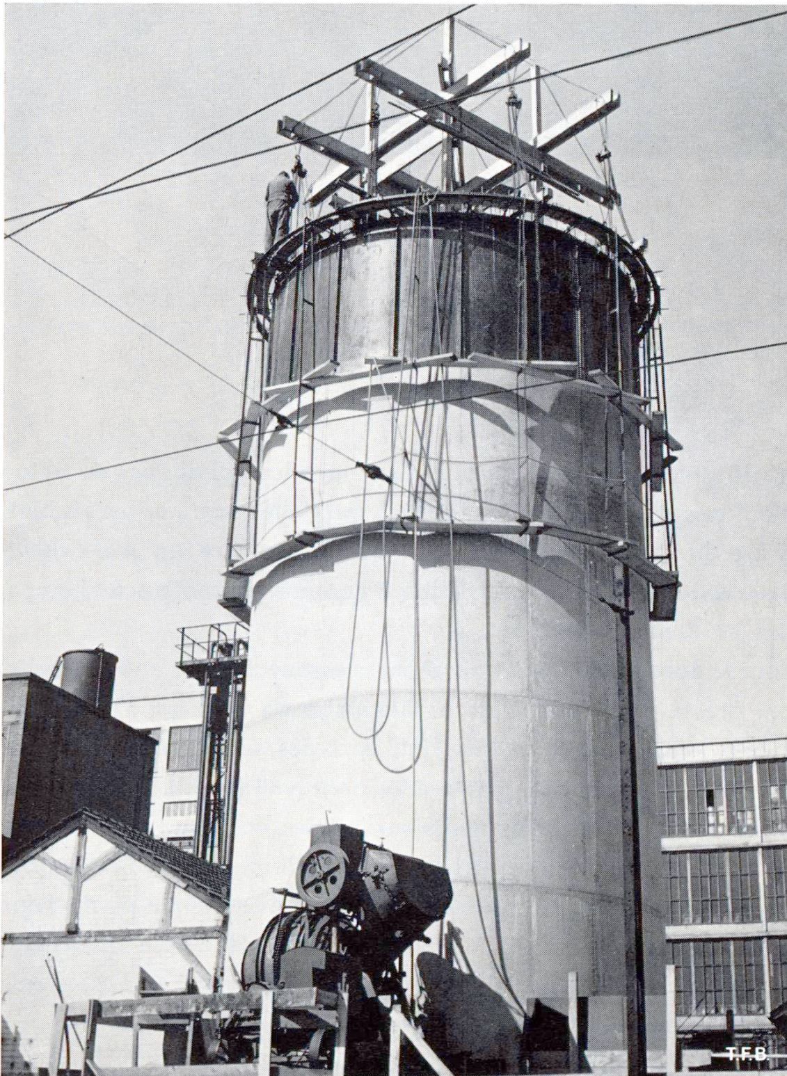
Fig. 3 Cheminée de la CIBA en construction
