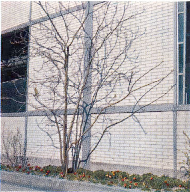
Halle d'une fabrique en charpente métallique et garnissage en briques silico-calcaire
