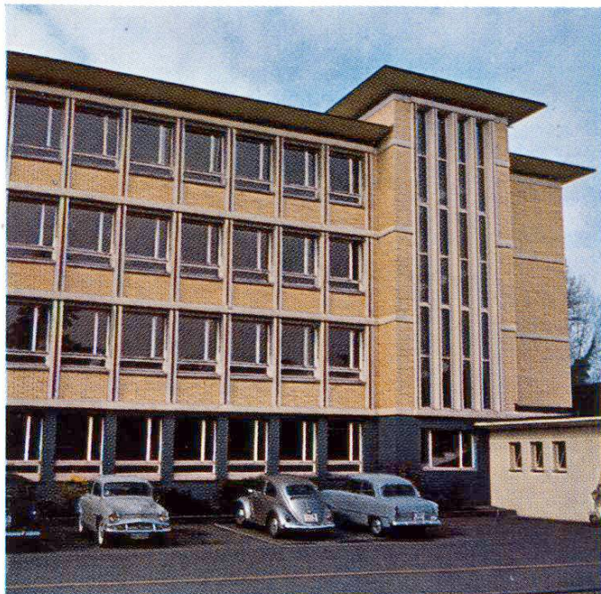
Bâtiment administratif. Charpente en béton armé avec garnissage en maçonnerie de terre cuite (Architecte: E. Heer, Zurich)
