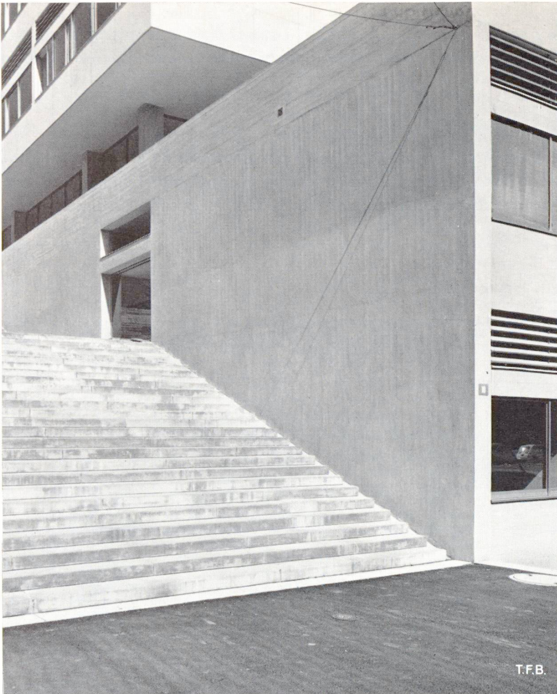
Fig. 7 Les grandes surfaces du béton apparent posent des exigences particulièrement sévères en ce qui concerne leur régularité. Les plus petits écarts dans les proportions du mélange, dans son homogénéité ou sa teneur en eau peuvent provoquer des différences de teinte. Sur cette photo, la partie supérieure paraît ne pas avoir atteint le même degré de durcissement que la partie inférieure. La différence de teinte devrait donc disparaître avec le temps
