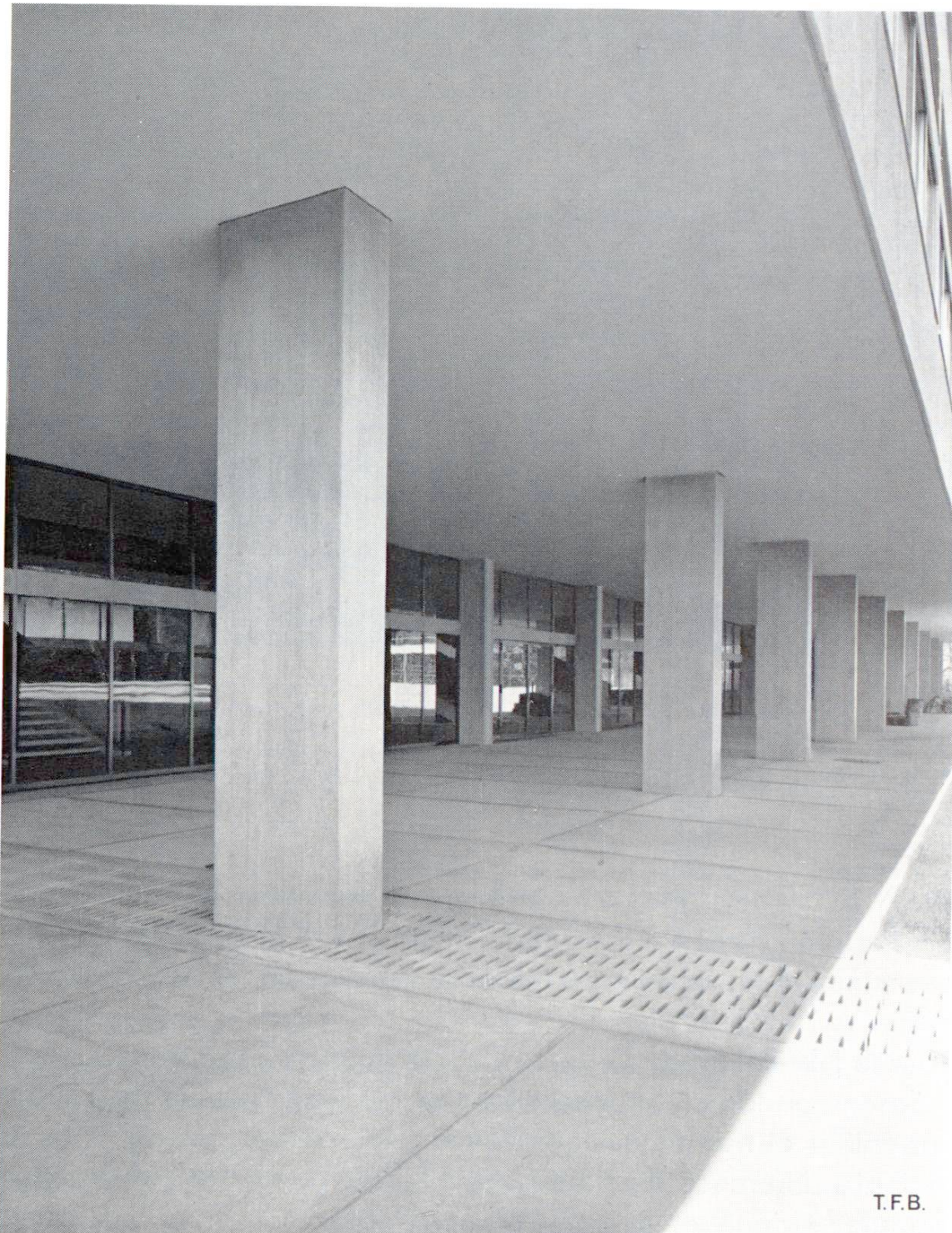
Fig. 6 Piliers en béton apparent
