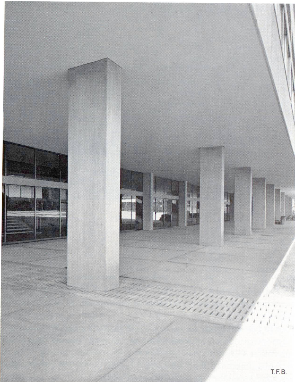
Fig. 6 Piliers en béton apparent
