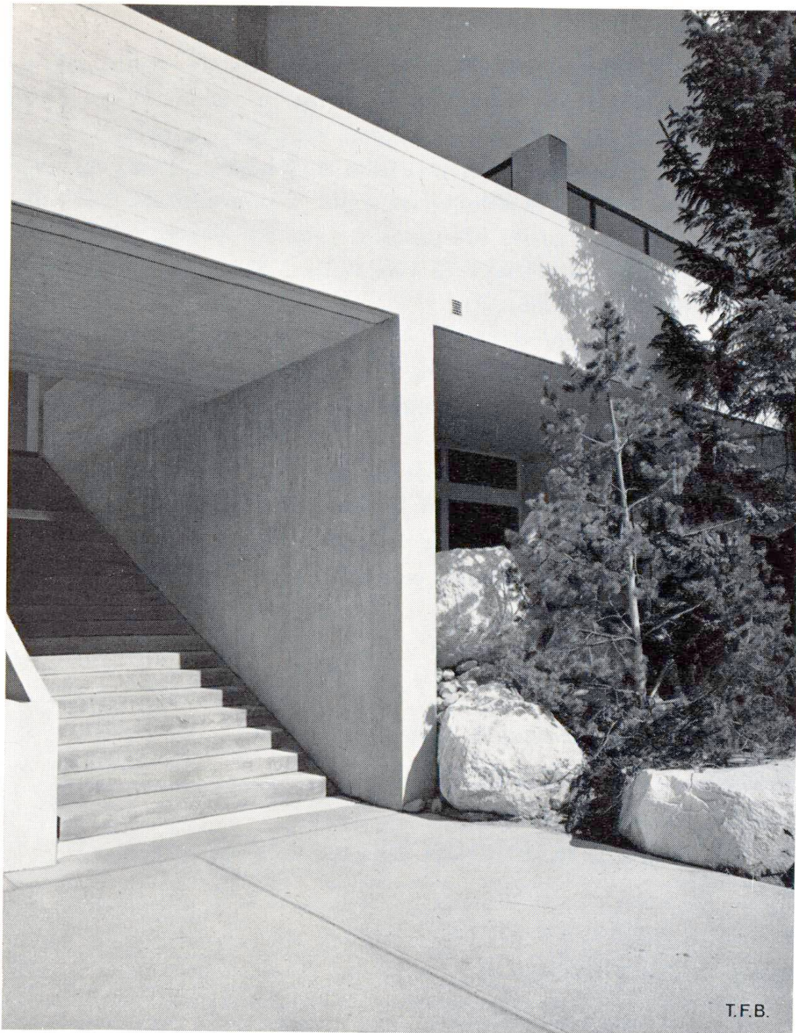
Fig. 3 Entrée de l'escalier en plein air. Pierres naturelles et artificielles créent un contraste agréable. Les marches d'escalier et la couverture du parapet supérieur ont été bétonnées sur place, mais indépendamment du reste
