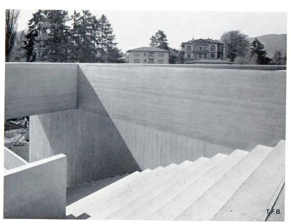
5 (comparez aux figures 1 et 2 du BC N° 18/1957). Il n'a pas été fait usage d'huile de coffrage, ceux-ci furent simplement arrosés abondamment avant le bétonnage. Les planches ont pu être réutilisées plusieurs fois.
