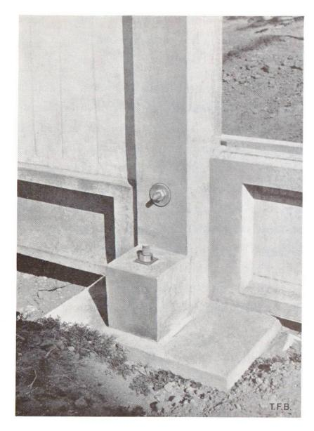
Fig. 4 Les éléments de béton soigneusement moulés sont faciles à assembler et à fixer
