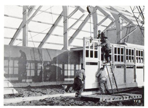
Fig. 2 Montage d'un bâtiment en éléments préfabriqués en béton et en bois
