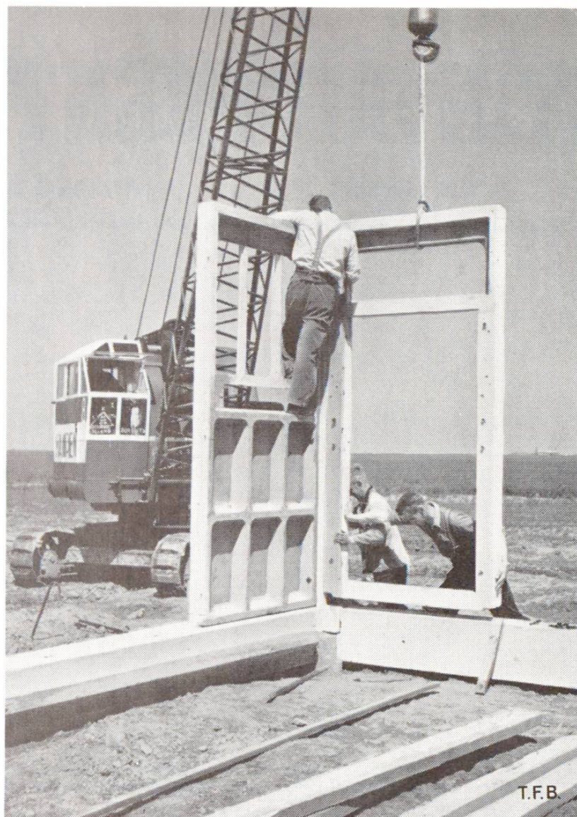
Fig. 1 Construction de bâtiments agricoles sur les terrains nouvellement conquis sur le Zuidersee (Hollande). Une petite grue facilement mobile est utilisée pour le montage des éléments de parois
