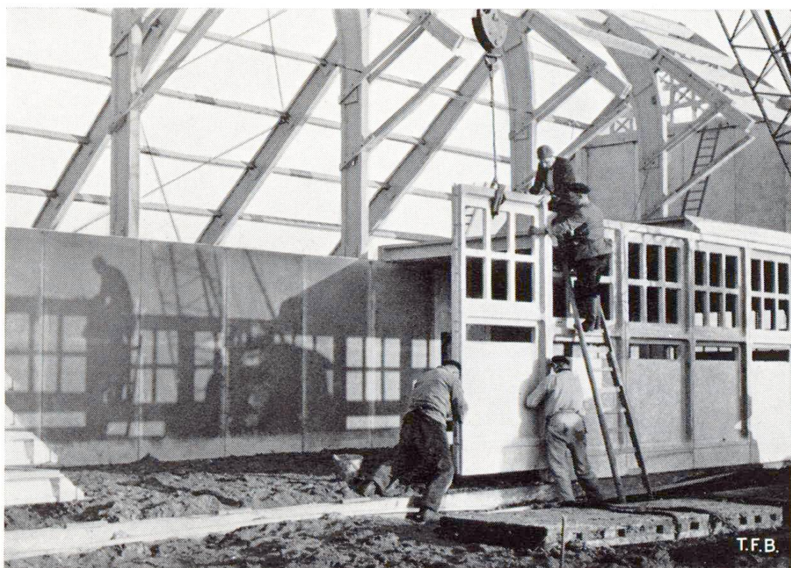
Fig. 2 Montage d'un bâtiment en éléments préfabriqués en béton et en bois
