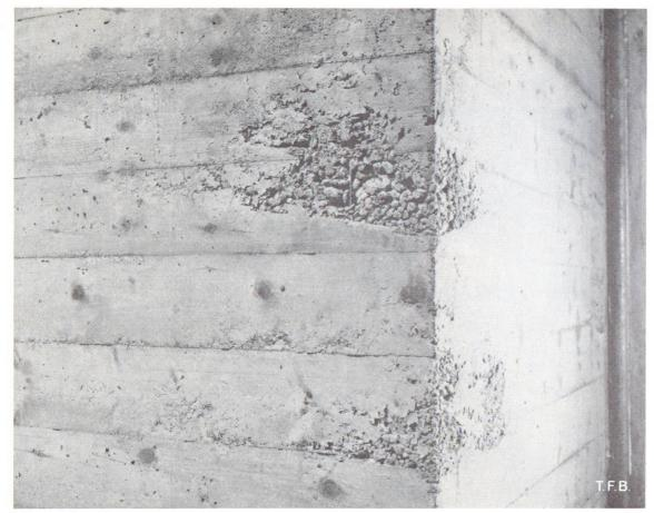
Fig. 3 Nids de gravier dans un angle de mur. La mise en place du béton doit être particulièrement soignée en de tels endroits
