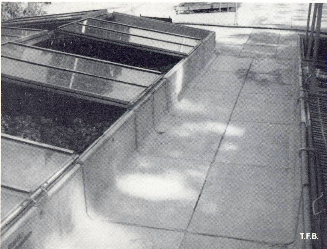
Fig. 12 Couches en béton préfabriqué
