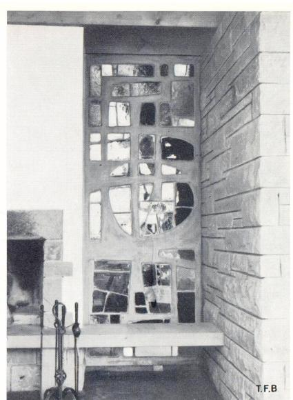
Fig. 13 Vitrail artistique dans lequel les verres colorés sont enchassés dans une structure de béton (A. Zahner, Rheinfelden)
