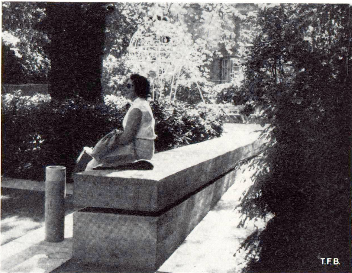
Fig. 8 Muret en béton sans crépi
