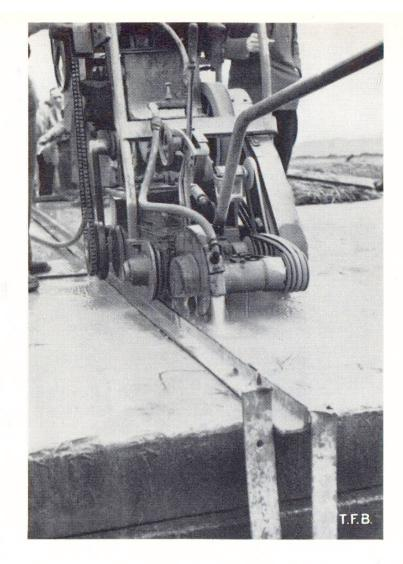
Fig. 10 Entaille du joint dans le béton durci au moyen d'une scie à disque
