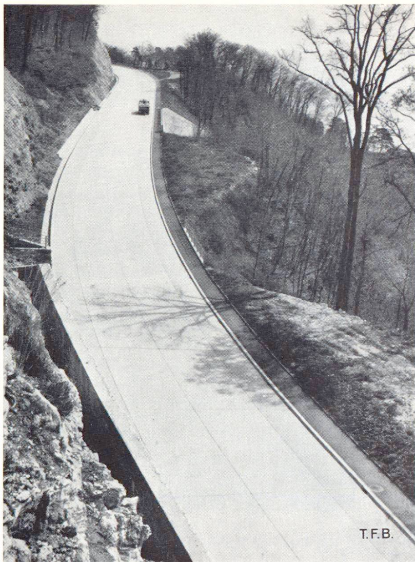
Fig. 12 La route en béton dans le Bois de la Lance près de Concise. Chaussée en béton clair, bandes cyclables teintées en rouge
