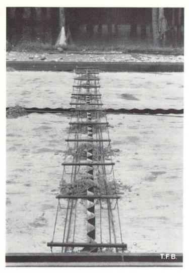
Fig. 5 Construction moderne de joints. Joint médian et joint transversal avec éternit ondulé et goujons. Le béton placé sur ce dispositif sera entaillé (Fig. 8—10). Du fond de cette entaille jusqu'à l'éternit ondulé s'établit une fissure oblique, alternativement à gauche et à droite, qui crée l'engrènement désiré augmentant l'effet des goujons
