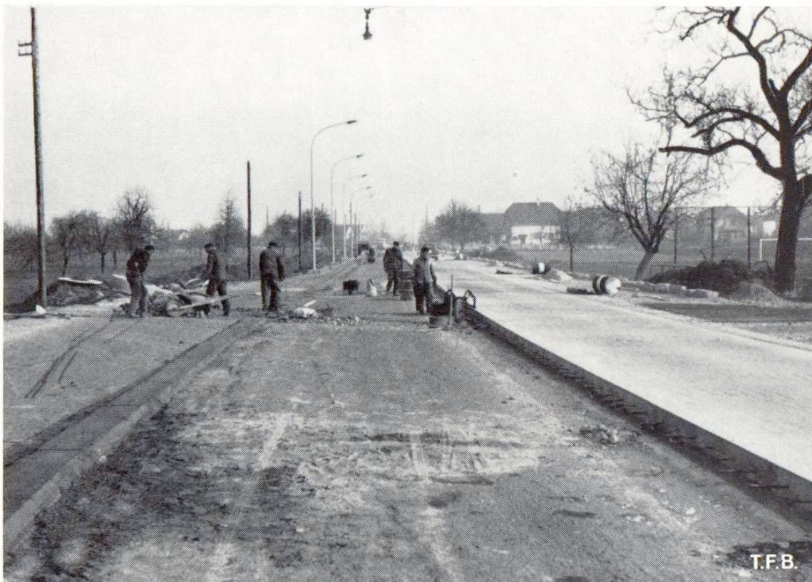
Fig. 4 Préparatifs avant le bétonnage du revêtement. A droite, revêtement terminé avec fers de liaison; à gauche, la couche de réglage et le lit de mortier pour la pose des coffrages
