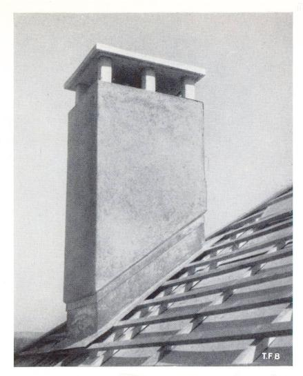
Fig. 4 Cheminée crépie au mortier du chaux hydraulique. Dans un tel ouvrage, les effets de l'humidité et de la chaleur sont particulièrement développés et le raccord avec la toiture difficile à réaliser. Il faut donc un crépi possédant une grande ductilité
