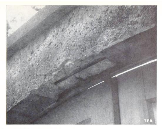
Fig. 3 La partie inférieure de cette voussure avait été recouverte d'un crépi au ciment épais et très gras. La différence des comportement de ce crépi trop dur et de son support (un béton relativement maigre avec un crépi à la chaux), a provoqué de nombreuses fissures du premier, puis sa destruction
