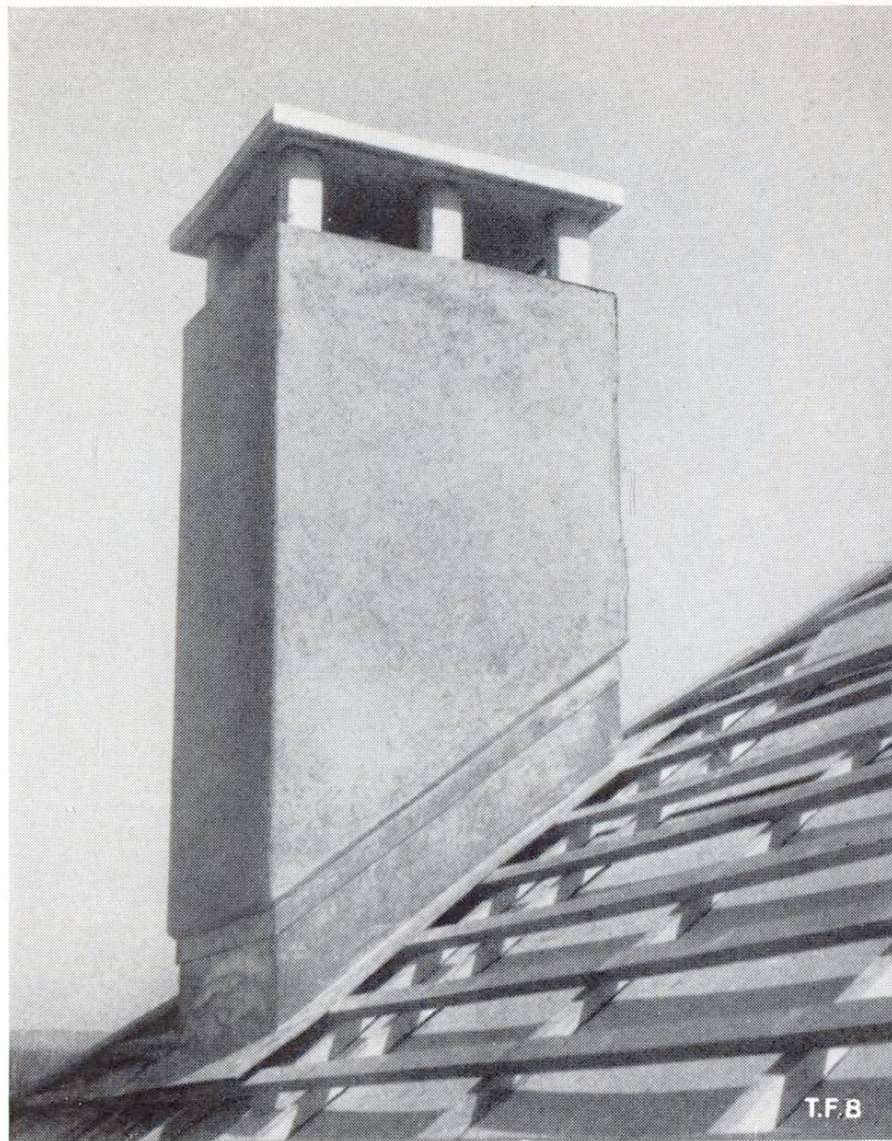
Fig. 4 Cheminée crépie au mortier du chaux hydraulique. Dans un tel ouvrage, les effets de l'humidité et de la chaleur sont particulièrement développés et le raccord avec la toiture difficile à réaliser. Il faut donc un crépi possédant une grande ductilité
