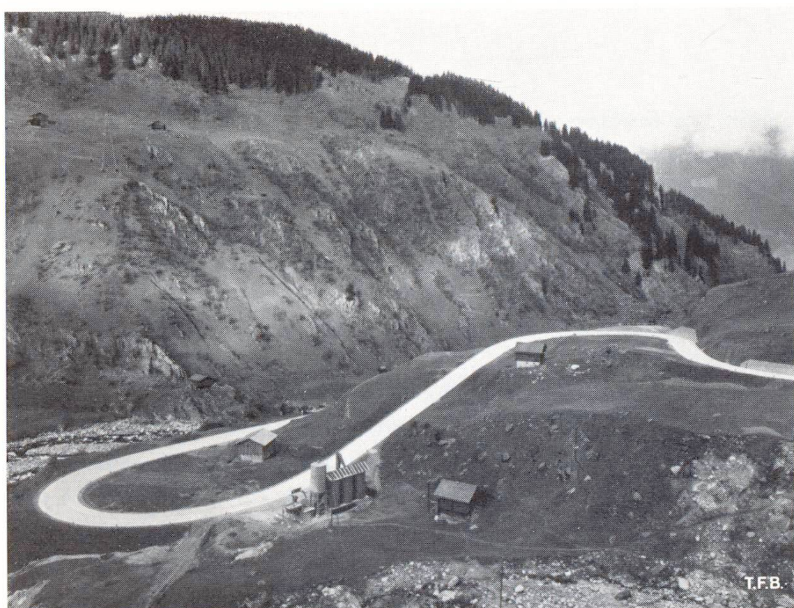
Fig. 7 En dessous de Curaglia, la route en lacet largement améliorée. Au premier plan, une centrale à béton pour la construction de la route, avec concasseurs, silos à pierres, silo à ciment, bétonnière et silo à béton
