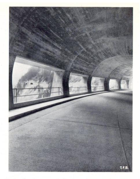
Fig. 4 Galerie de protection dans la gorge entre Disentis et Curaglia. Le béton de la voûte, les piliers et la chaussée créent une très grande luminosité dans ce passage et donnent un sentiment de pleine sécurité
