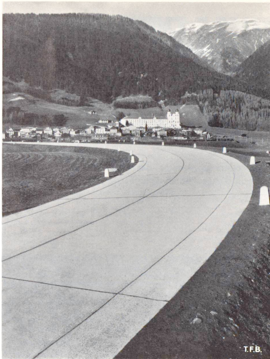
Fig. 2 Grande courbe au point 1126, avec élargissements de la chaussée. Vue vers Disentis. Les deux bandes centrales ont chacune 3 m de large
