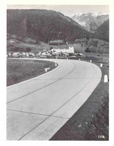
Fig. 2 Grande courbe au point 1126, avec élargissements de la chaussée. Vue vers Disentis. Les deux bandes centrales ont chacune 3 m de large
