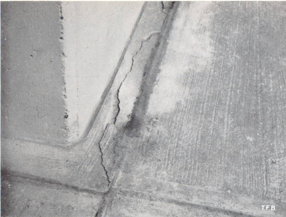
Fig. 5a et b Rupture du béton d'un revêtement le long d'un mur (voir aussi fig. 2). Le joint devrait être exactement au droit du bord de la fondation alors qu'il se trouve 5 mm à côté. Il a suffi d'un léger soulèvement du dallage par le gel pour provoquer ces dégâts. La photo de droite montre très clairement le cas; on y voit même la trace du carton bitumé à côté du joint superficiel
