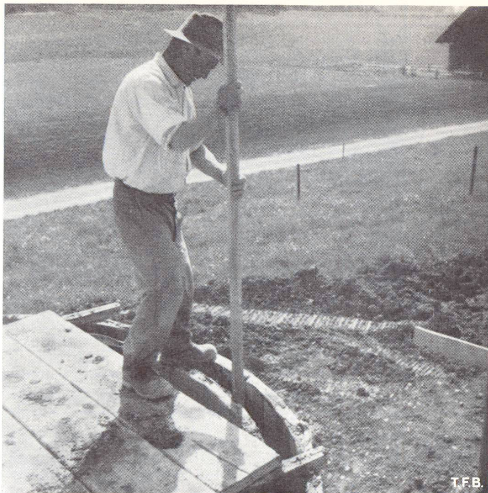
Fig. 7 Le bétonnage d'un silo à fourrage vert. Béton semi-plastique damé énergiquement. Les fourrages ensilés contenant des substances qui attaquent le béton, l'intérieur des silos doit être muni d'un enduit protecteur. On utilise pour cela des produits bitumineux ou des verres solubles (Talc : Silicate de soude : eau = 4 : 3 : 4). Ces enduits doivent être renouvelés chaque année (coût frs. 1.50 à 2.50 par m 2 ). Il existe aussi des enduits plus durables à base de caoutchouc ou de résine synthétique, mais ils coûtent jusqu'à frs. 9.— le m 2 . Des essais sont en cours actuellement pour mettre au point un enduit qui assurerait une protection permanente.
