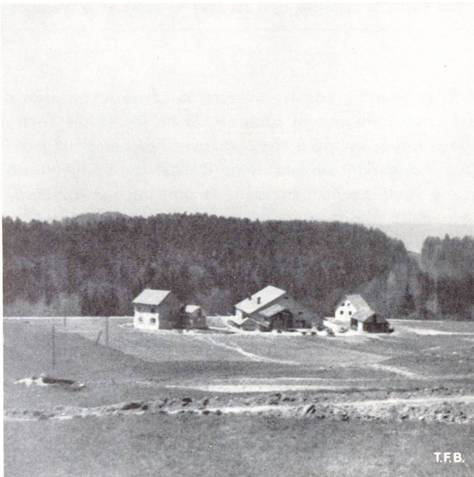
Fig. 2 Ferme complètement neuve dans un territoire remanié de la commune d'Affoltern a. A. A droite la maison des ouvriers agricoles. (Fig. 8)
