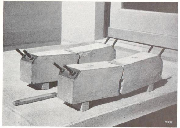
Fig. 2 Prismes d'essai en béton précontraint fabriqués en 1940 par le T. F. B.
