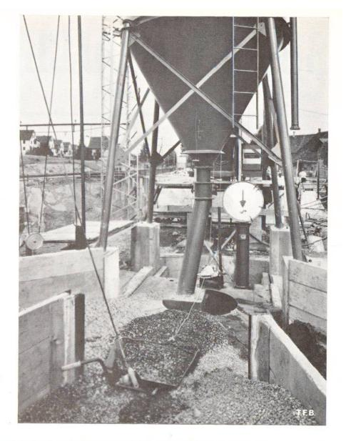
Fig. 1 Installation moderne de préparation du béton avec agrégat livré en trois composants et dosage pondéral
