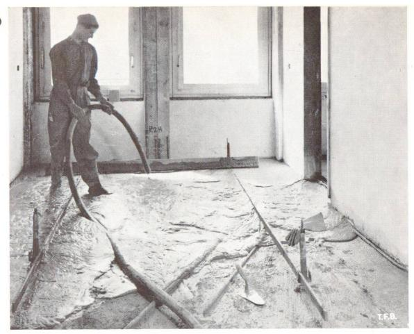
Fig. 6 Mise en place de béton cellulaire pour l'isolation d'un plancher (Photo: Engler, Winterthur).
