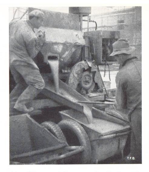
Fig. 4 Préparation de béton cellulaire sur un chantier au moyen d'une bétonnière spéciale. La consistance est liquide.
