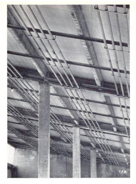
Fig. 7 La charpente formée des fermes et des pannes et l'installation de chauffage suspendue au plafond. (Photo: Jürg Ganz.)
