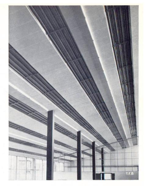
Fig. 8 Vue intérieure de la halle terminée. Le faux plafond est constitué par des plaques d'isolation acoustique.
