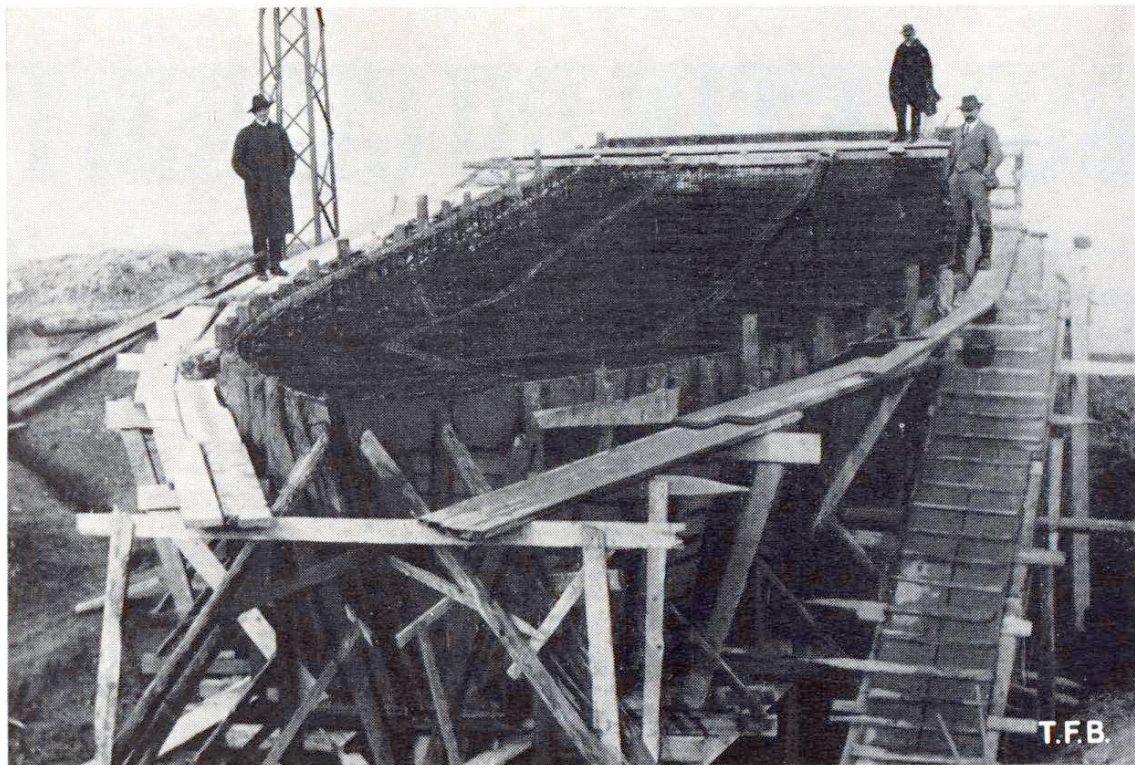
Fig. 1 Vue de la construction du « Seeland ». On reconnaît l'armature du pont renforcée dans les bords et les deux poutres parallèles se réunissant à la proue
