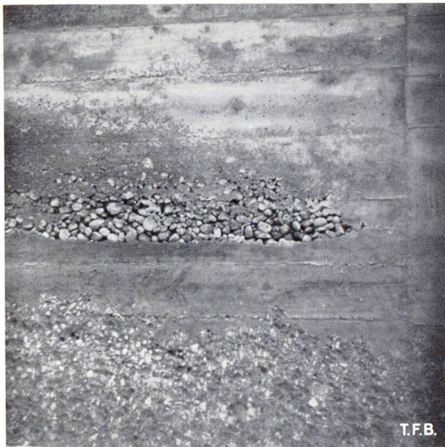
Fig. 4 Pourquoi ce nid de gravier? Parce que le béton a été déversé directement dans le coffrage relativement haut, à partir de la benne de transport. On aurait pu l'éviter en déchargeant le béton sur un pont et en remplissant le coffrage à la pelle
