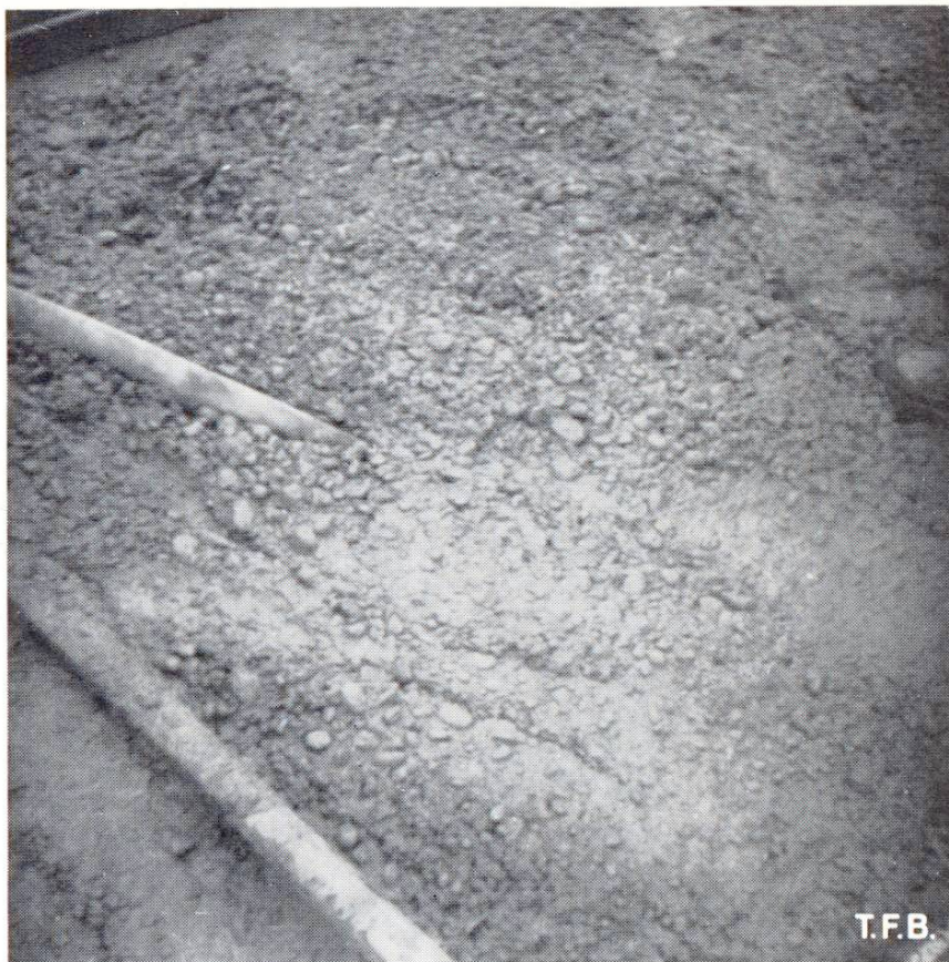
Fig. 5 En vibrant convenablement un béton faiblement plastique, il devient presque liquide. La vibration exclut donc l'emploi de béton liquide
