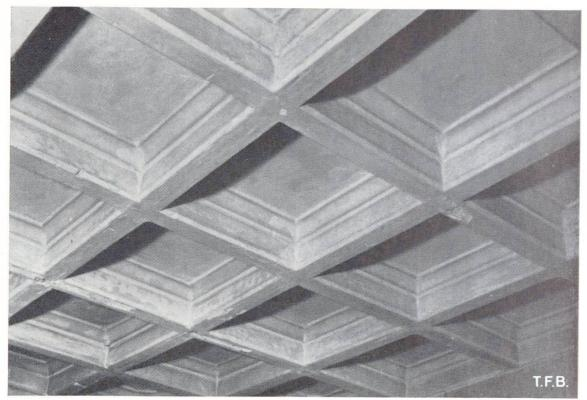
Fig. 3 Plafond du rez-de-chaussée constitué par des caissons en plâtre séparés par un intervalle qui est bétonné, de même que la dalle qui les recouvre
