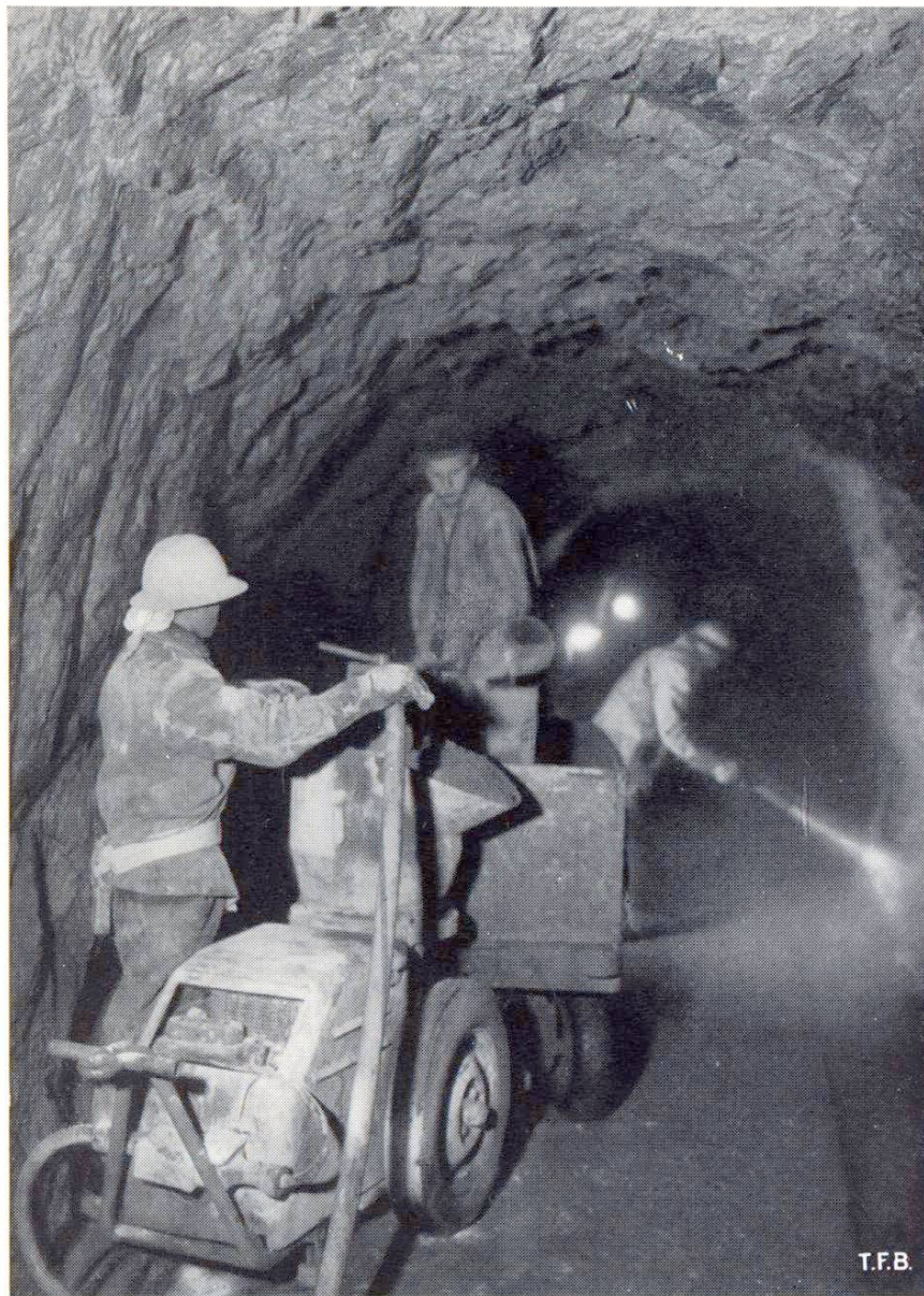
Fig. 1 Installation de galerie pour béton projeté
