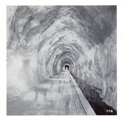
Fig. 4 Galerie à écoulement libre avec revêtement en béton projeté de l'entreprise de la Maggia. (Photo F. M. M.)
