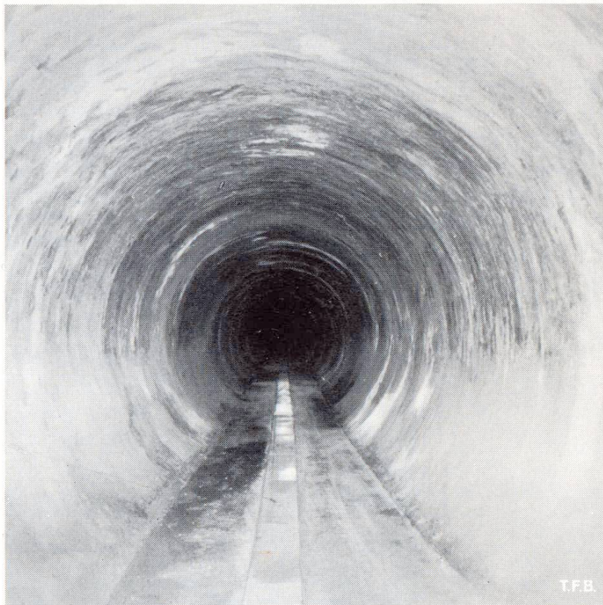
Fig. 6 Revêtement en béton projeté « tiré » au profil exact dans une galerie en charge de l'entreprise de la Maggia. (Photo F. M. M.)
