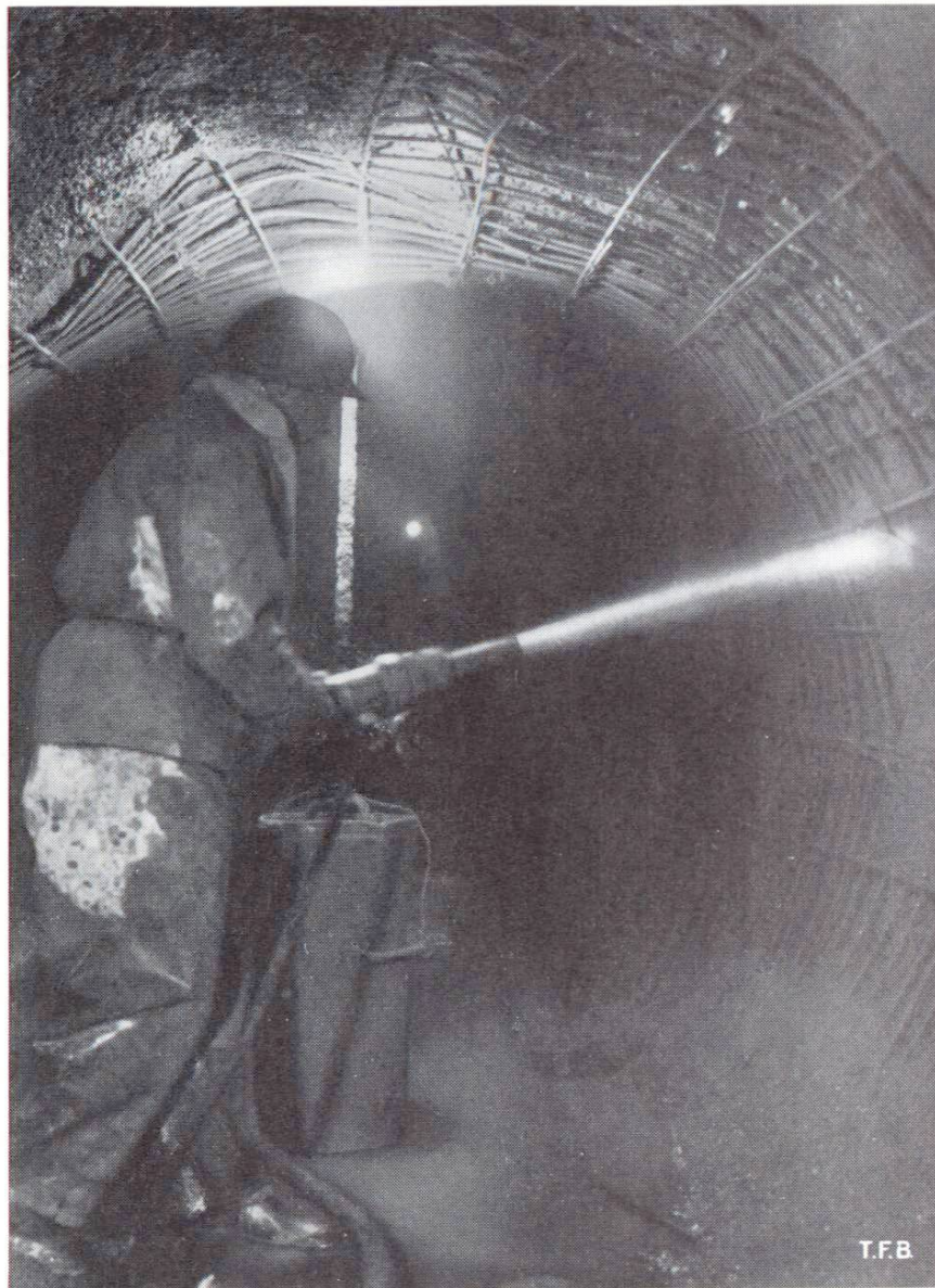
Fig. 3 Revêtement armé en gunite pour rocher particulièrement friable
