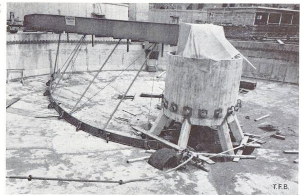
Fig. 4 Un bassin de décantation en construction. Au milieu, l'arrivée des eaux sales dans le petit bassin cylindrique, à la périphérie, le déversoir crénelé pour l'évacuation des eaux traitées. Sur le fond, le racloir qui, par un lent mouvement de rotation, amène les boues au centre d'où elles seront ensuite évacuées
