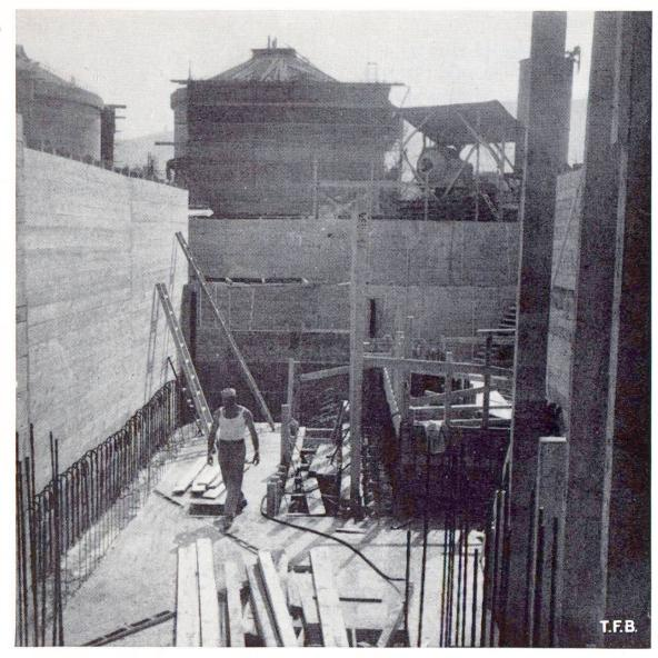
Fig. 2 Bétonnage du bâtiment des pompes. Ce dernier contient aussi l'installation de dégrillage, le déchiqueteur et le dessableur. A l'arrière plan, on reconnait les deux digesteurs de 900 m³ chacun
