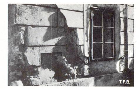
Fig. 5 Décollement d'un enduit appliqué en trop grande épaisseur sur une surface trop lisse. L'épaisseur de chaque couche d'enduit ne devrait pas dépasser 2 cm
