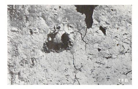
Fig. 1 Fissures de retrait et décollement d'un mortier trop gras
