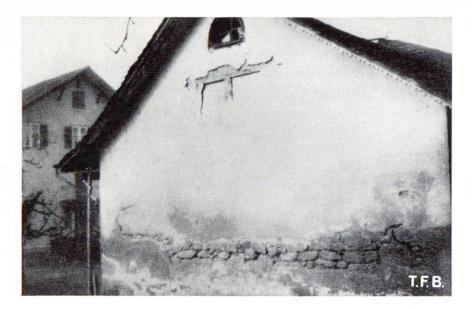
Fig. 2 Enduit endommagé, en bas par l'humidité provenant du sol, en haut par le comportement différent du bois et de la maconnerie (support non homogène)
