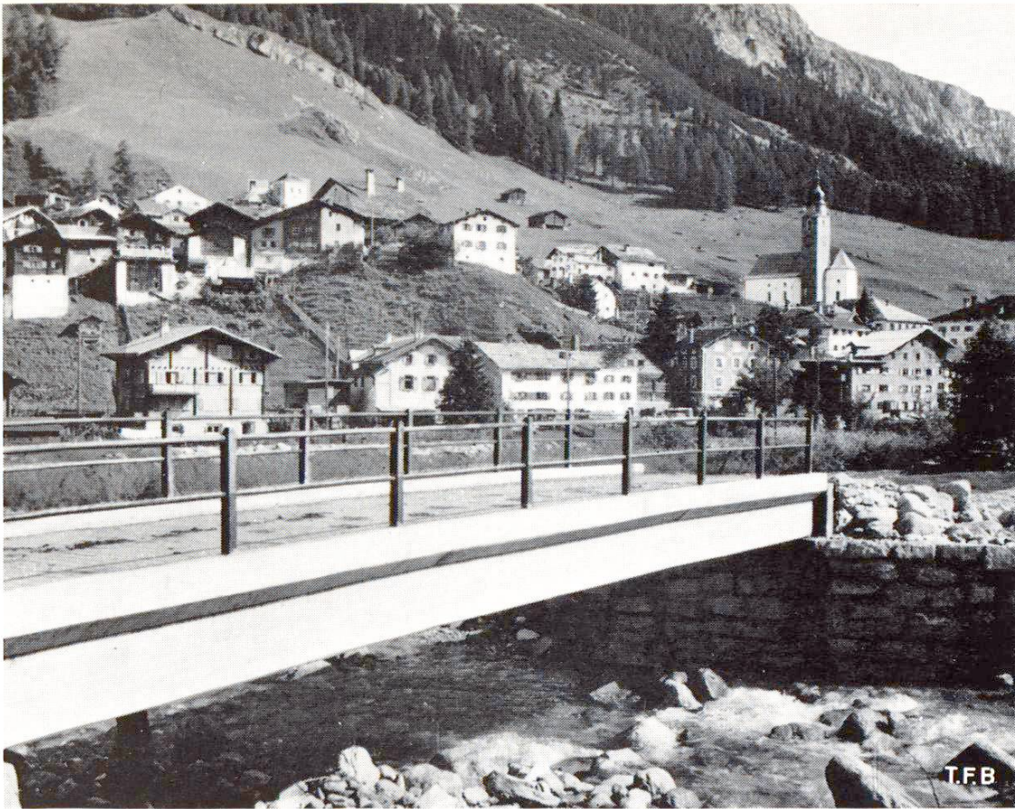
Fig. 3 Petit pont en poutres préfabriquées en béton. Portée 13 m
