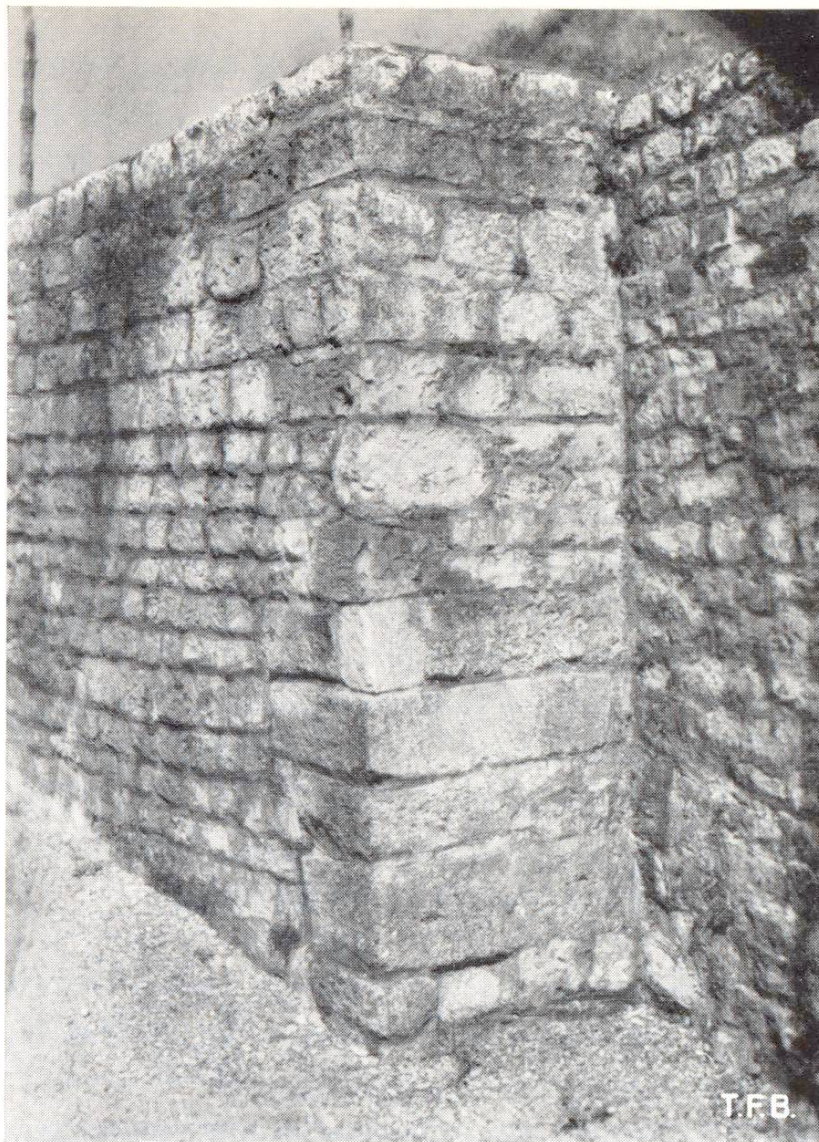
Fig. 3 Maçonnerie romaine du 3 e siècle ap. J.-C. joint- toyée au mortier de chaux hydraulique. Parement bien dressé et pierres posées à assises réguli- ères forment une maçon- nerie très stable avec une quantité réduite de mortier
