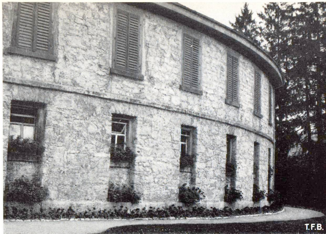
Fig. 5 Maçonnerie plus récente en moellons bruts. La qualité de la chaux hydraulique a permis d'utiliser ici des moellons très peu travaillés et par conséquent peu coûteux
