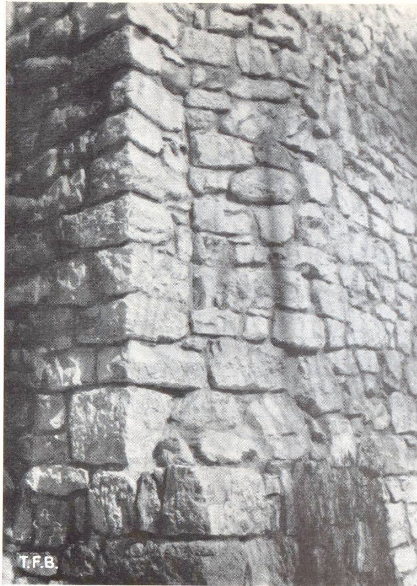
Fig. 4 Maçonnerie médiévale as- semblée au mortier de chaux hydraulique
