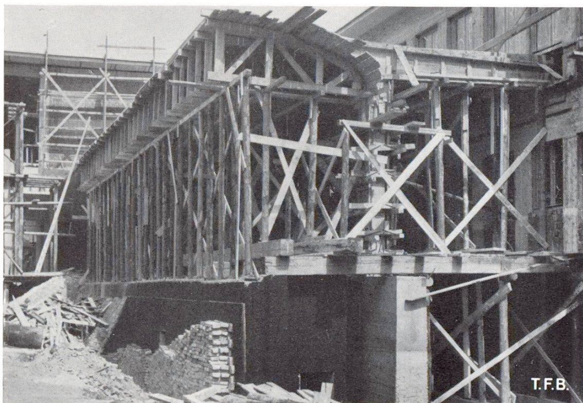
Fig. 2 Coffrage de la couverture en avant-toit d'un quai longeant un bâtiment. Au fond, bâtiment administratif avec squelette en béton.
