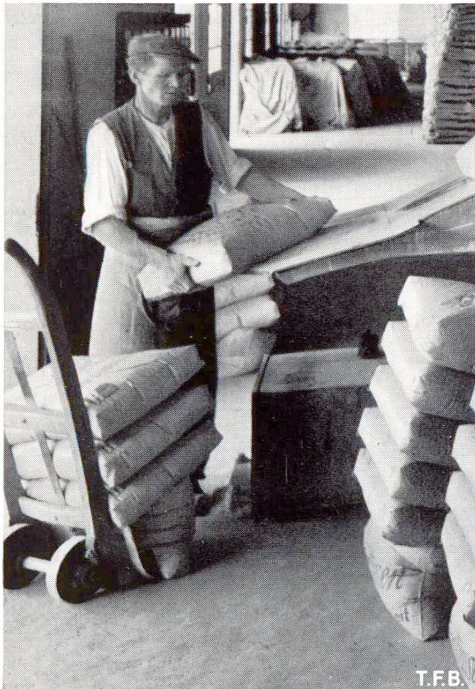
Transport de sacs de ciment au moyen d'un diable
