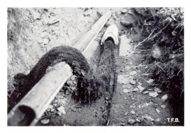
Fig. 2 Queue de renard autour d'un câble de 50 000 volts
